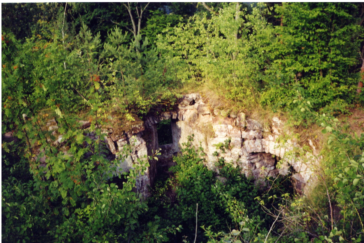
Vue du gros bastion depuis le rocher nord en 1999.
