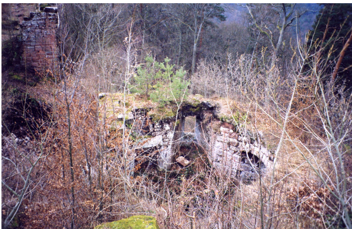
Vue du gros bastion depuis le rocher nord en 2000.
