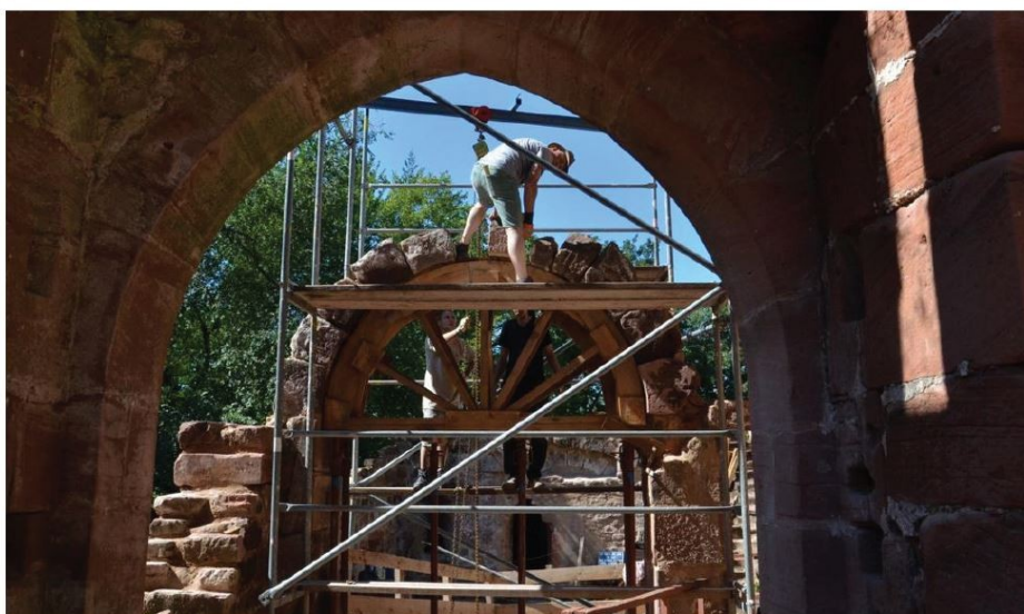
Cet été, des compagnons maçons ont remis à leur place des éléments du château du Schoeneck tombés dans la cour. Une découverte libre de la ruine est programmée aujourd'hui de 10 h à 18 h (rendez-vous sur le parking de la D53 entre Wineckerthal et Obersteinbach). PHOTO DNA
