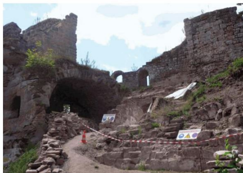
Le chantier de la ruine du Schoeneck. DOCUMENT REMIS.
