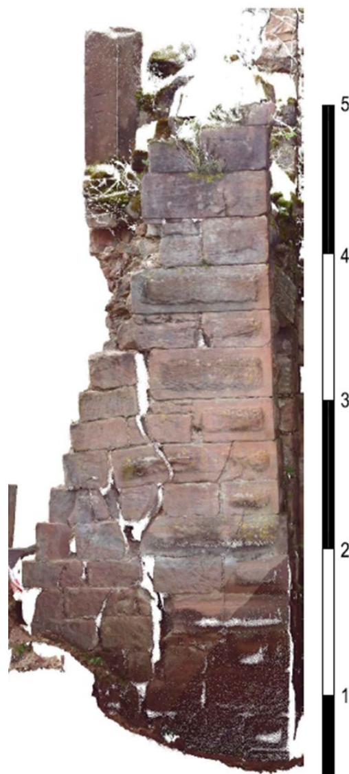
Scan de la courtine est dans la tour avant son démontage
