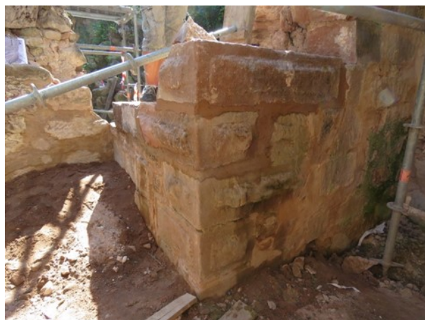
Vue sur l'angle de la courtine dans la tour
