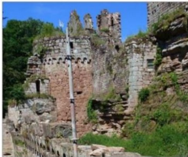
Les bénévoles de l'association ont procédé à de nombreux travaux de restauration durant l'année Photo DNA/Photo Marc SCHAMPION
