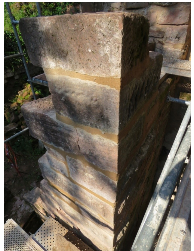
Mur d'angle du rempart est dans la tour.
