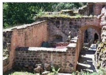
Ce logis de style Renaissance était enseveli sous un talus. Photo DNA
