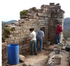
Pendant le jointoyage
