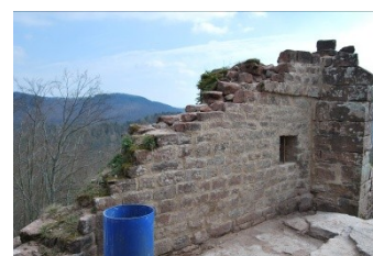
Résultat final après brossage des joints
