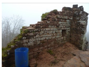
Le mur a été entièrement déposé et reposé pour être consolidé
