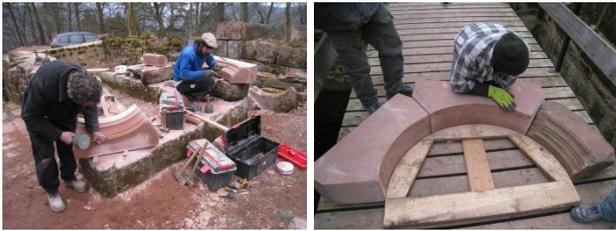
Retaille des éléments de l'arc de la porte et contrôle des joints
