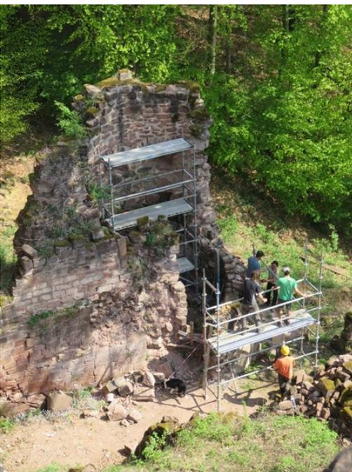
L'architecture de la tour étant déjà complexe de base, l'installation de l'échafaudage a été laborieuse : il fallait qu'il englobe les deux côtés du mur fissuré afin de pouvoir travailler dessus, tout en étant parfaitement stabilisé au milieu des empilements de pierres.
