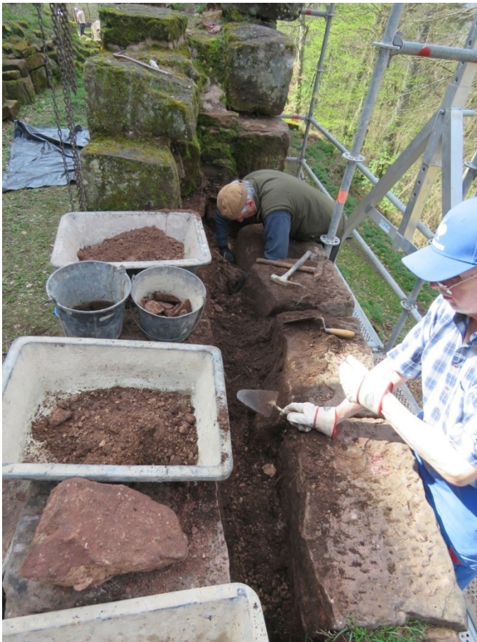
Purge du blocage du mur.
