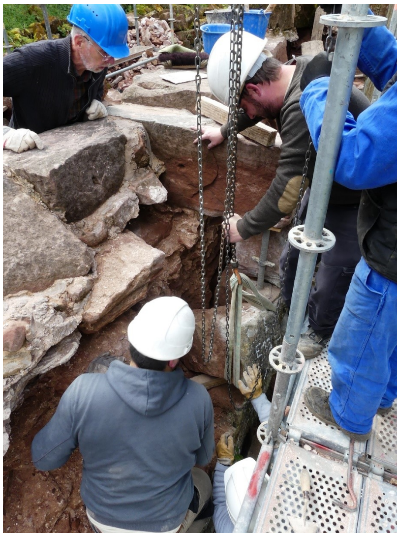
Extraction d'un bloc de la muraille. 66 gros blocs ont été déposés en avril. Il en reste deux à déposer sous la boutisse.
