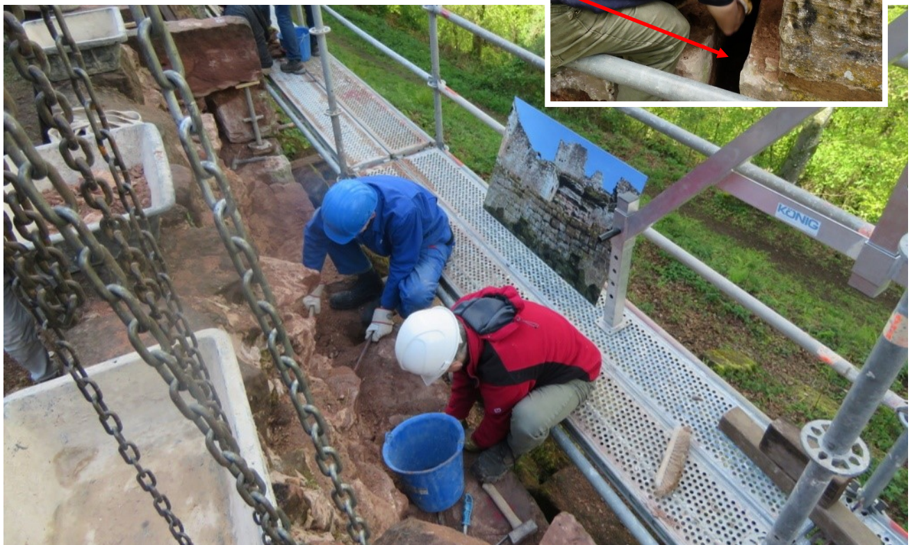
Canal d'évacuation d'eau traversant le rempart.
