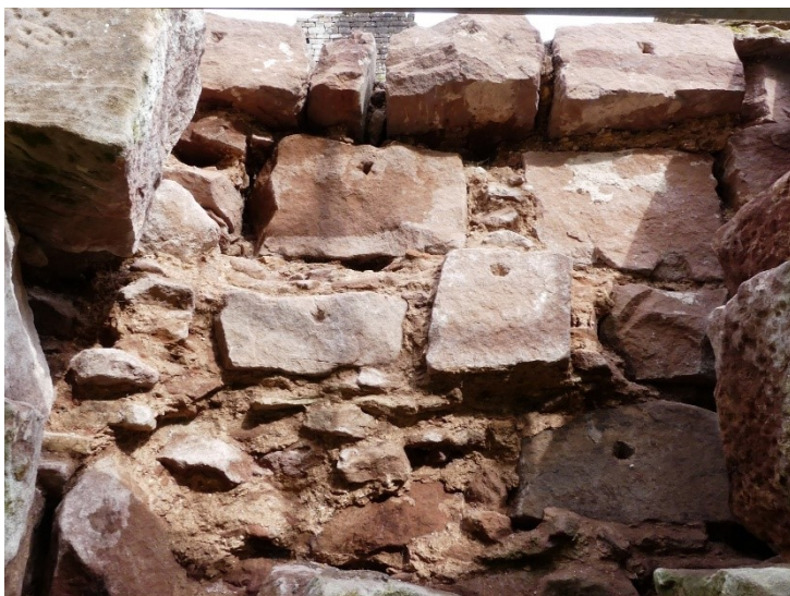
Arrière des blocs côté basse-cour. Le trou permettait d'agripper le bloc avec une pince : la louve.
