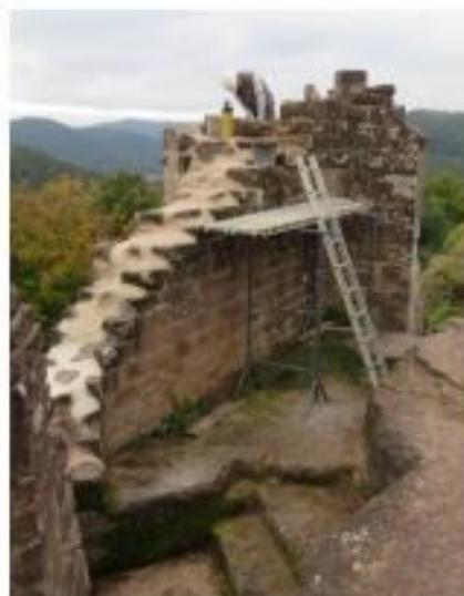
*Etanchéification des murs à l'entrée et au rocher nord.*
