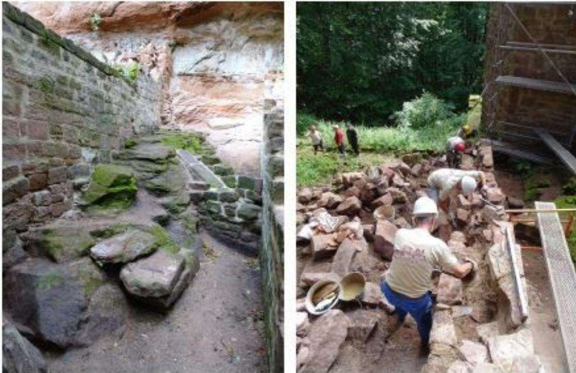
*Intérieur de la fausse-braie avec son canal d'évacuation et remontage de quelques blocs sur le parement extérieur du mur de la fausse-braie.*
