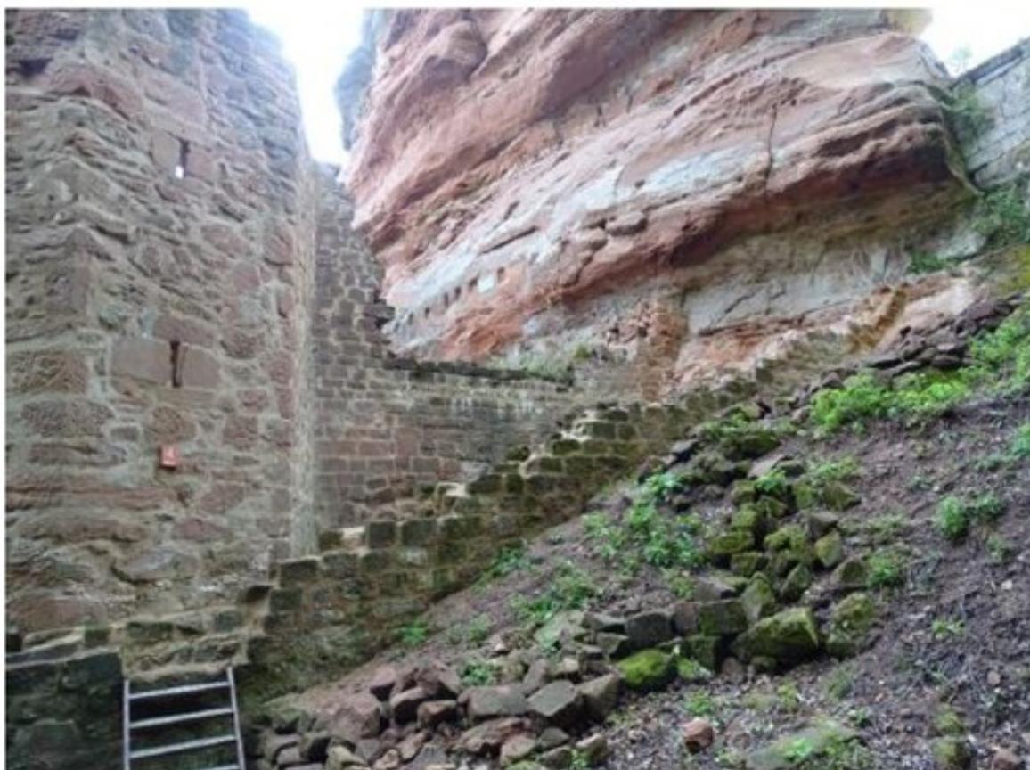
Concernant la maçonnerie, nous avons fait quelques joints au soubassement du bastion sud-est, à la niche avec banquette entre les deux rochers et pour assurer la pérennité du mur Est du logis nord, l'étanchéité d'un dessus de mur a été refaite.
