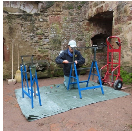
Assemblage de nouveaux tréteaux.
