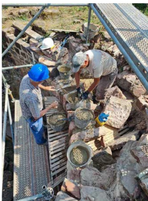
Pose des blocs de l'arc. Photo : Olivier Schwartz
