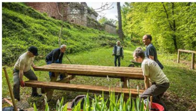
Installation de la nouvelle table. Photo : Daniel Georges
