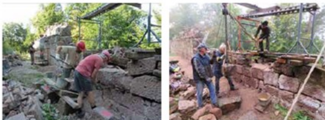
Remise en place des blocs de la courtine ouest en 2019.
