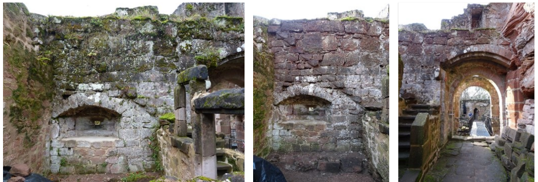
Avant les travaux en novembre 2019 et après nettoyage du mur.
