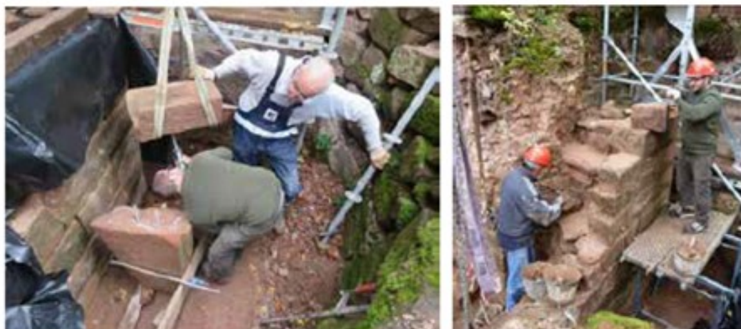
Goujonnage, collage puis pose du bloc dans la tour octogonale.
