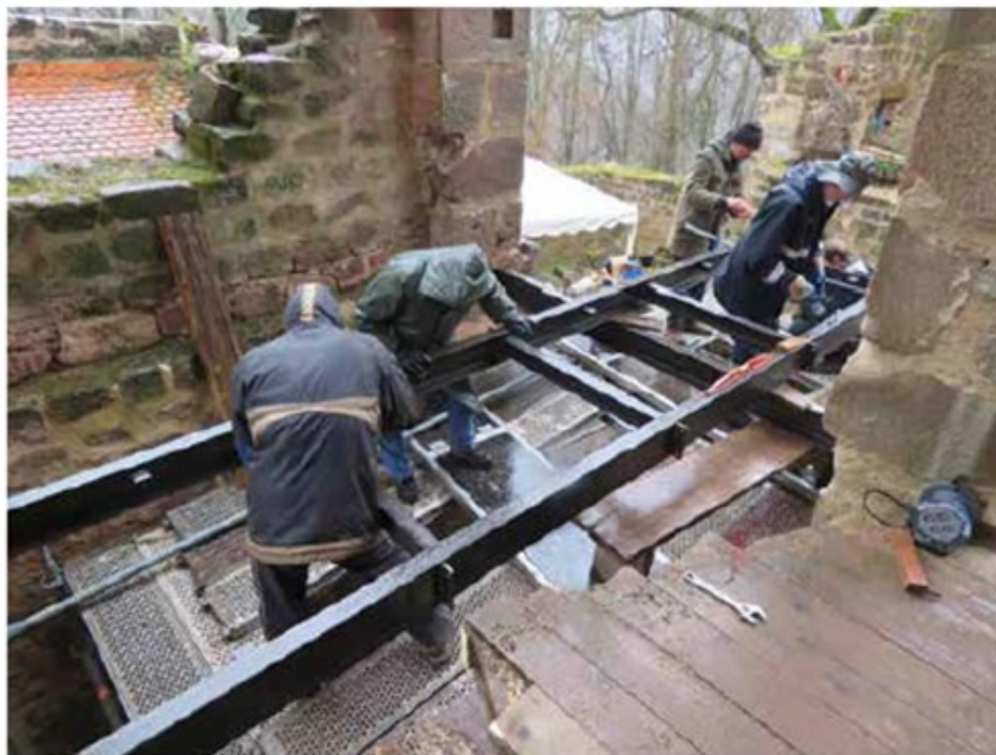
Installation de la nouvelle passerelle en mars 2019.
