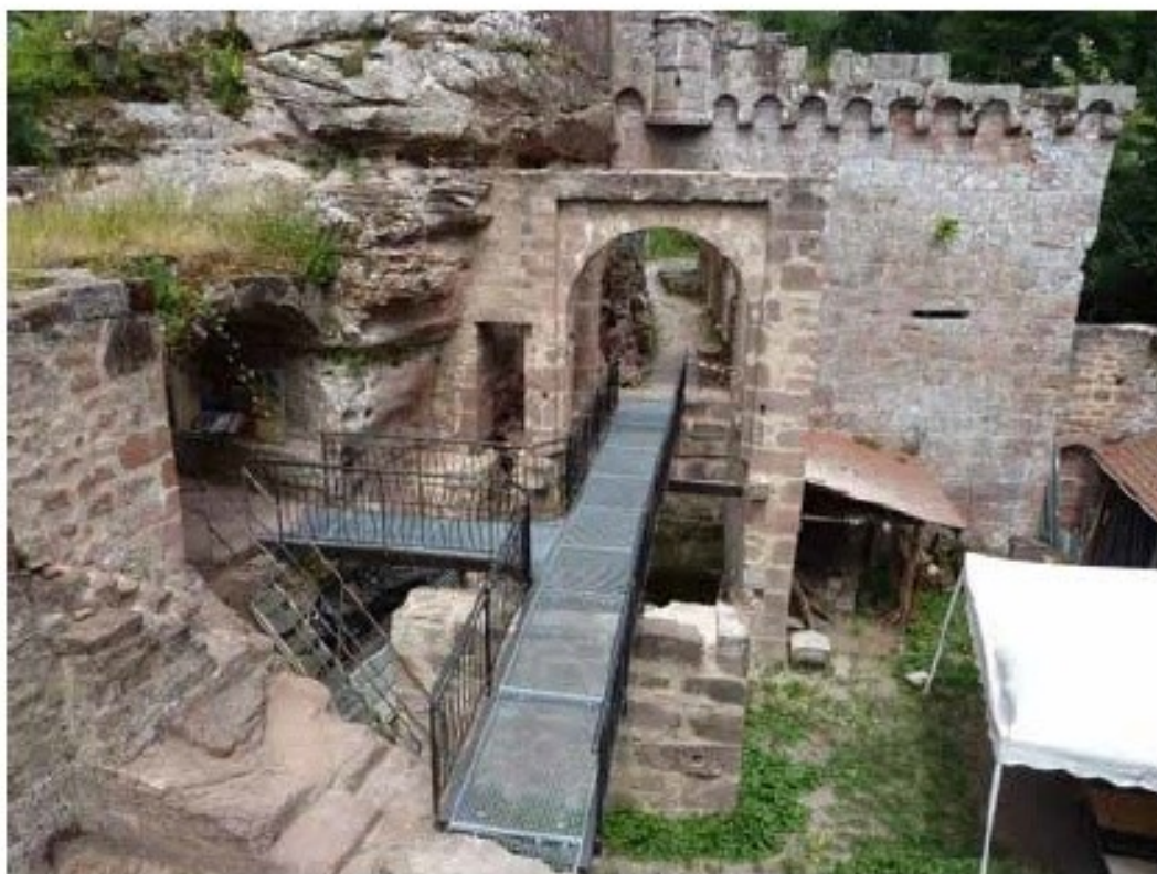
Nouvelle passerelle en 2019.
