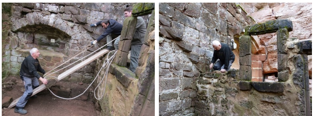
Dans la même pièce, nous avons déplacé une marche d'escalier qui était instable sur le mur pour la stocker au niveau du sol.
