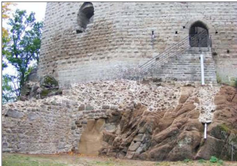
Des travaux financés sont en cours au Spesbourg actuellement et sur 12 ans explique le maire Fabien Bonnet. Photo Gilbert Mosser
