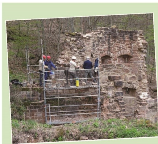
Travaux sur le mur bouclier nord
