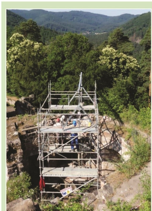
Construction de la voûte avec Dambach à l'horizon
