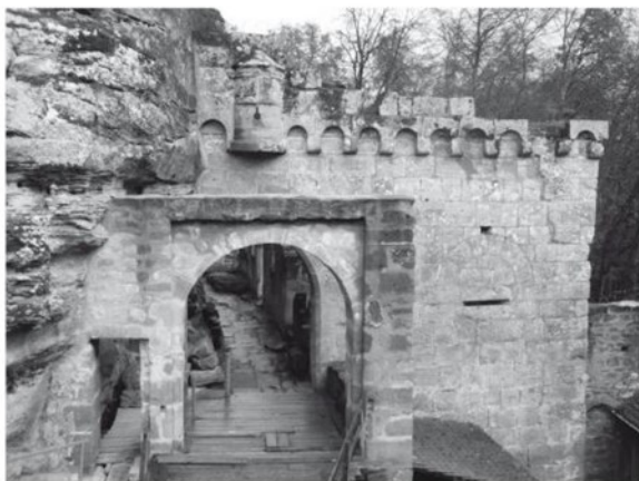
Poivrière avant (en haut à droite) et après les travaux (photos M. Schampion)
