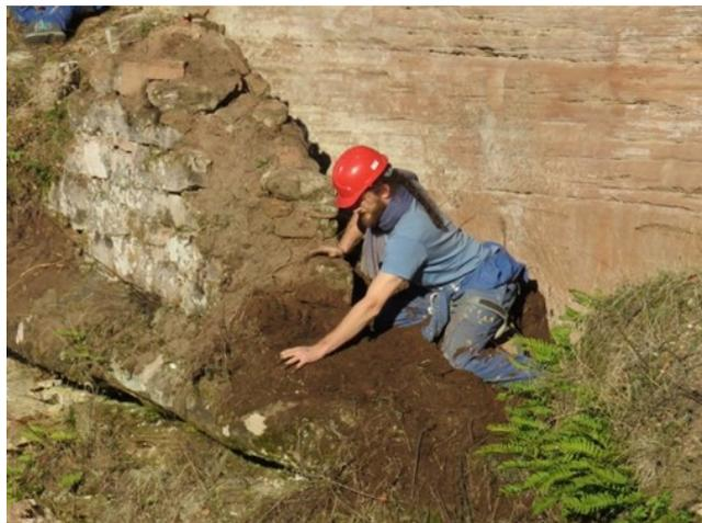
Nous continuons à assainir le chaînage d'angle nord-est de la courtine fait de belles pierres à bossage, entouré à la Renaissance par la tour semi-octogonale. Il s'agit de retrouver une base bien saine pour un remontage durable.
