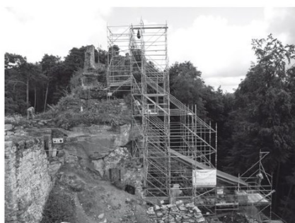
L'imposant échafaudage pour le logis Nord (photo Marc Schampion)
