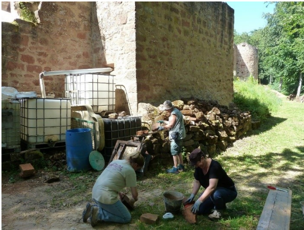
Nettoyage des briques en terre cuite et des chantiers suite au brossage des joints.
