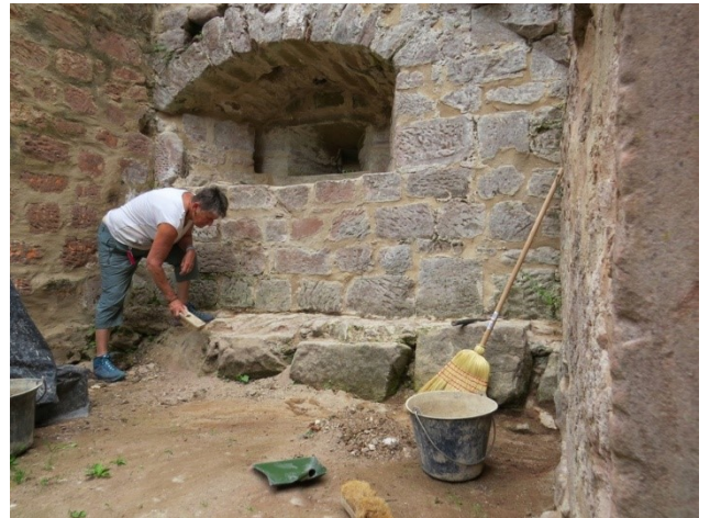
Nettoyage des briques en terre cuite et des chantiers suite au brossage des joints.
