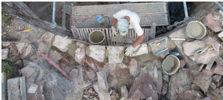
Quelques blocs du parement extérieur situés au-dessus de la fenêtre ont été repositionnés correctement et jointoyés. L'opération a été réalisée avec un harnais de sécurité attaché à l'échafaudage.
