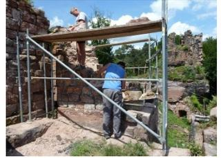
Les joints sur les faces interne et externe ont été réalisés, il ne reste plus qu'à couler une couche de mortier hydrofuge pour protéger le mur.
