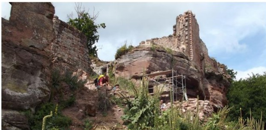
Une des façades du château du Schoeneck qui a été débarrassée de la végétation. Les bénévoles attendent l'autorisation pour remonter les murs, les pierres étant encore sur place. PHOTOS DNA
