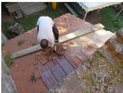
Nettoyage et remplacement des tuiles cassées de la toiture de la forge.
