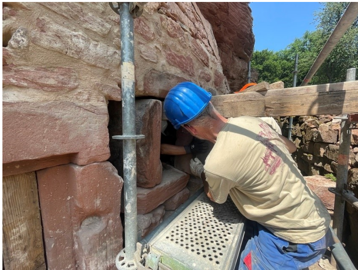
Dépose des montants de la fenêtre.
