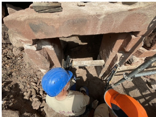
Repositionnement de la porte.
