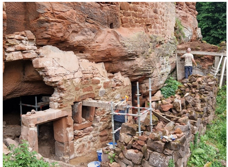
Au nord de l'abri, nous avons dégagé la porte de sa végétation pour consolider le mur qui s'était écroulé il y a quelques années.
