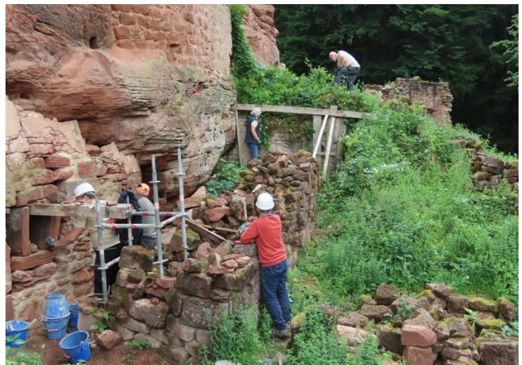
Au nord de l'abri, nous avons dégagé la porte de sa végétation pour consolider le mur qui s'était écroulé il y a quelques années.
