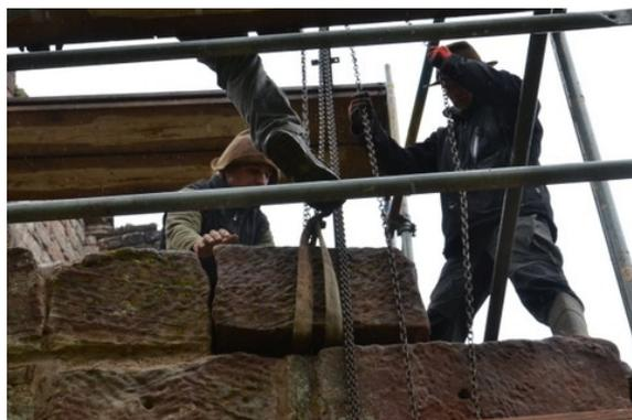
L'intervalle entre les parements extérieur et intérieur est rempli de blocage et de mortier, tous les blocs du rang supérieur sont reposés sur lit de mortier et alignés au pied de biche ou à la barre à mine.
