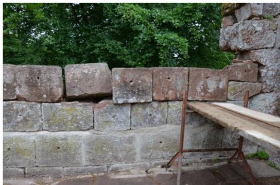
L'opération, effectuée en un samedi, à trois, a consisté à basculer les blocs sans changer leur position, à nettoyer la base et à remettre un lit de mortier avant de les rebasculer dans leur position initiale.
