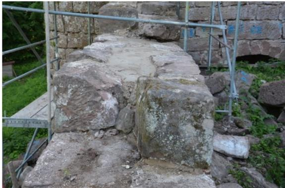
Le jointoiement effectué dans la foulée garantit une protection contre l'attaque de la végétation, stabilise les pierres et redonne à l'architecture une partie de son esthétique perdue.
