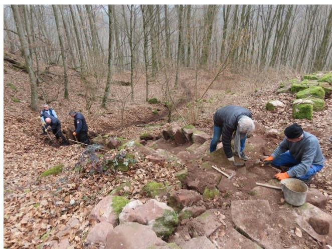
Il a fallu déplacer de gros blocs de pierre pour réaliser un bel escalier stable, pratique et sécurisé.
