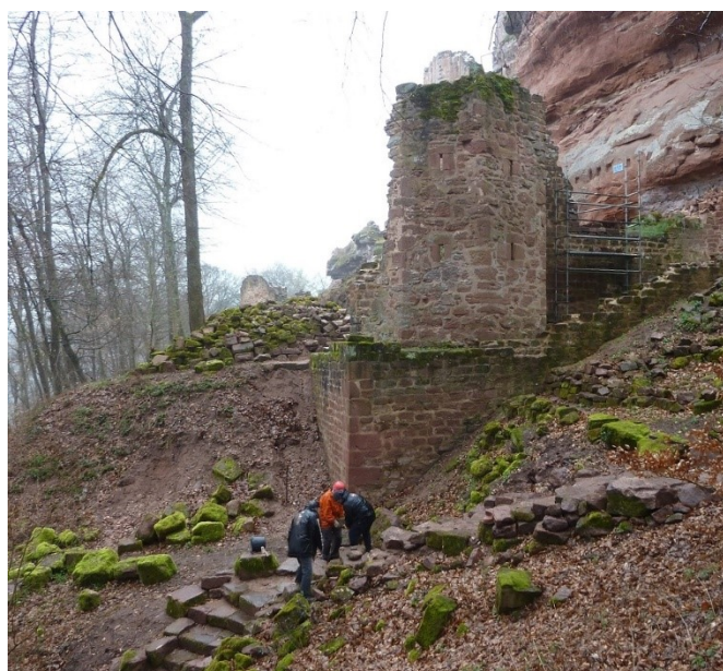
Il a fallu déplacer de gros blocs de pierre pour réaliser un bel escalier stable, pratique et sécurisé.
