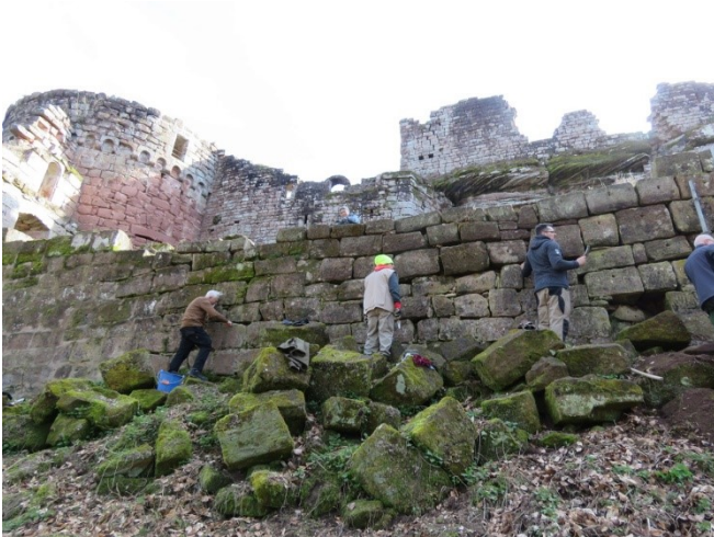
Brossage du parement et montage de l'échafaudage extérieur.
