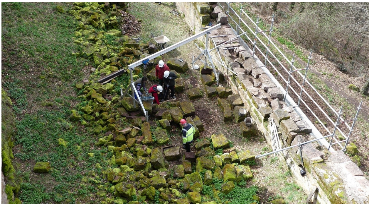
Déplacement des blocs posés dans la basse-cour avec un portique et une nouvelle pince de levage.
