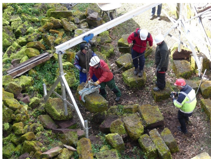
Déplacement des blocs posés dans la basse-cour avec un portique et une nouvelle pince de levage.
