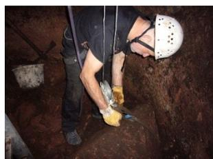
Arrimage du bloc avec une sangle de levage
