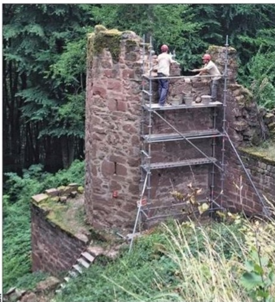
Deux maçons bénévoles consolident le mur d'une tour.
