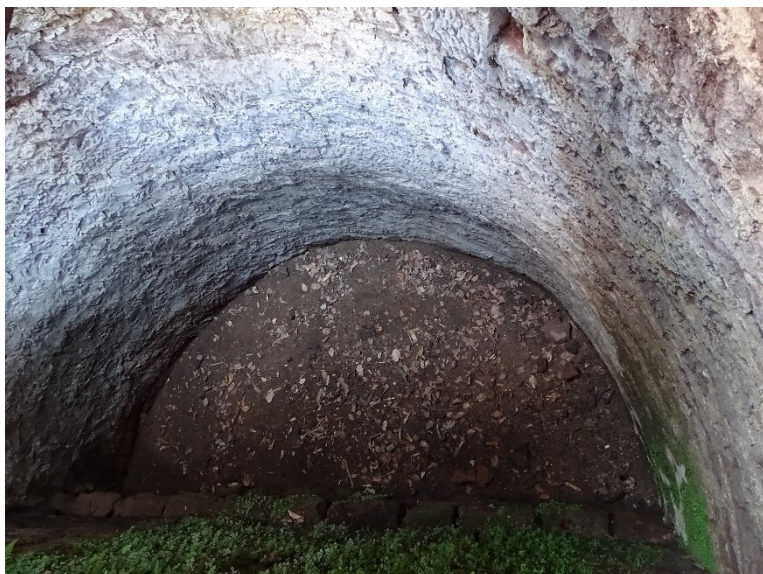
Le fond de la tour semi-circulaire sous le plancher.
