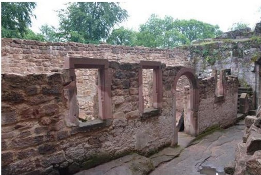
Fig. 29 Schoeneck - Façade du logis Renaissance après restauration des ouvertures (Photo Remy Valentin)
