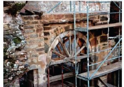
Les bénéfices réalisés grâce à la vente des fèves contribueront à financer des travaux au château. Ci dessus, l'avant-porte maçonnerie qui nécessite encore quelques finitions. DOC. REMIS
