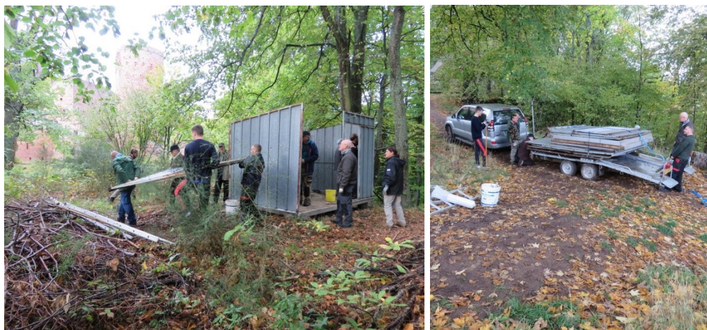
Démontage du cabanon aux châteaux d'Ottrott.
