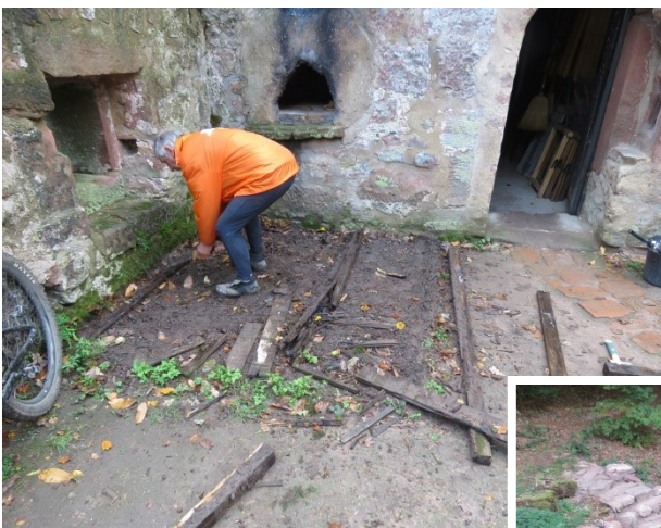
Démontage de la plateforme en bois.
