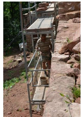
Le jointoyage progresse bien, l'ensemble du rempart côté extérieur est fait.
