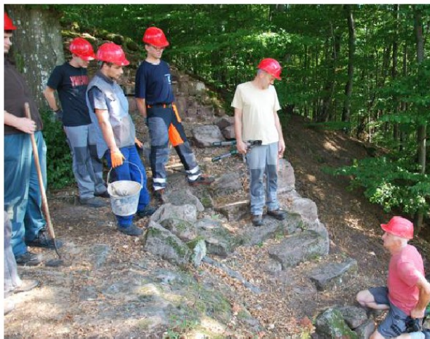
Jean a expliqué aux jeunes la nature des travaux à réaliser.
