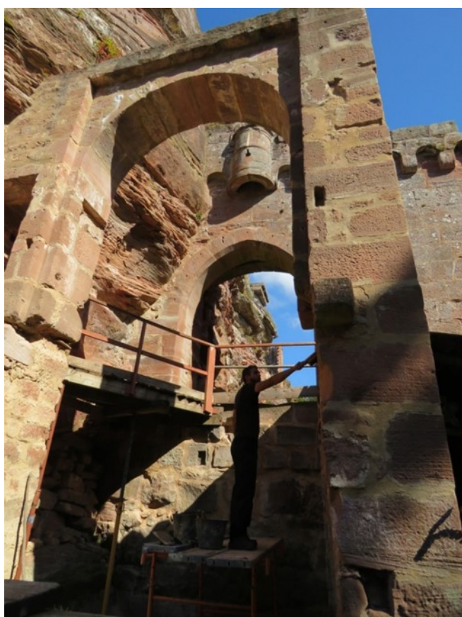
Quelques joints ont été réalisés sous l'avant-porte de la barbacane sud-est.
