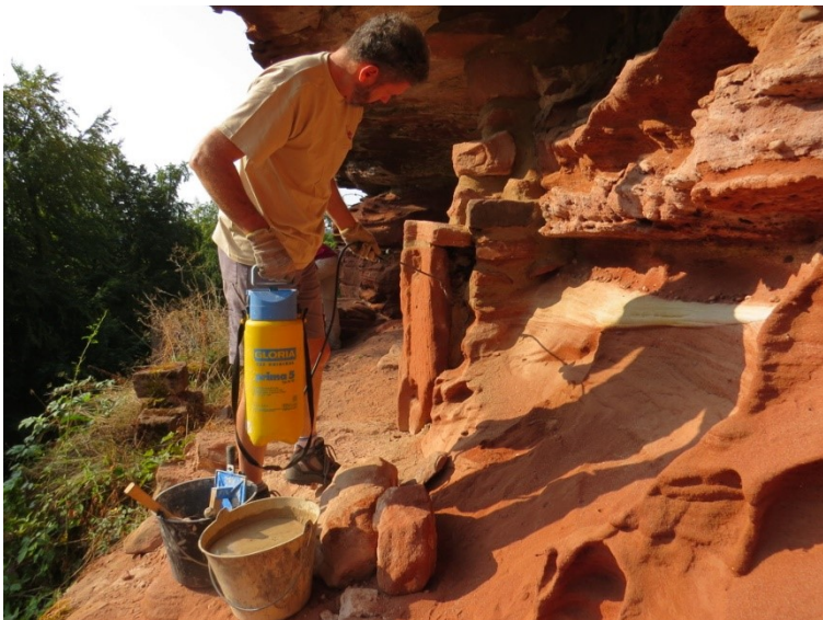
Humidification du grès avant application du mortier.
