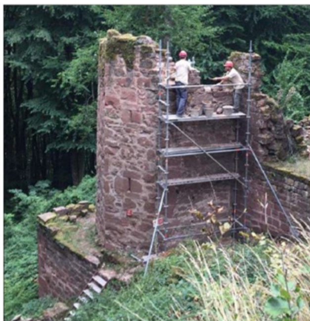
Deux maçons bénévoles en train de consolider les murs d'une tour. Photo RL
