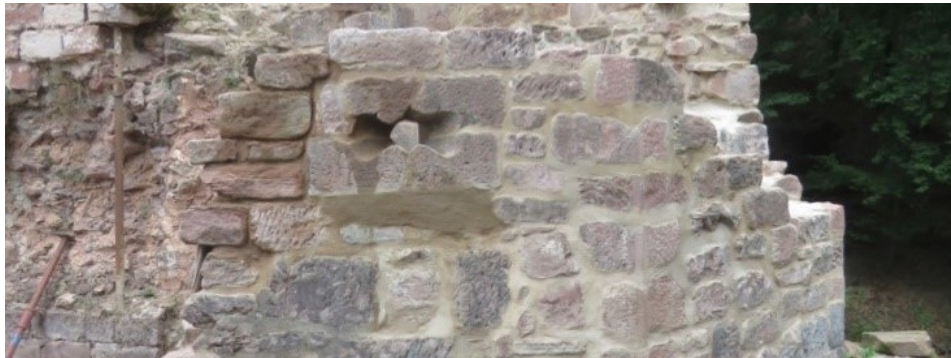
Les joints des dernières pierres posées à côté de la bouche à feu seront effectués l'an prochain.
