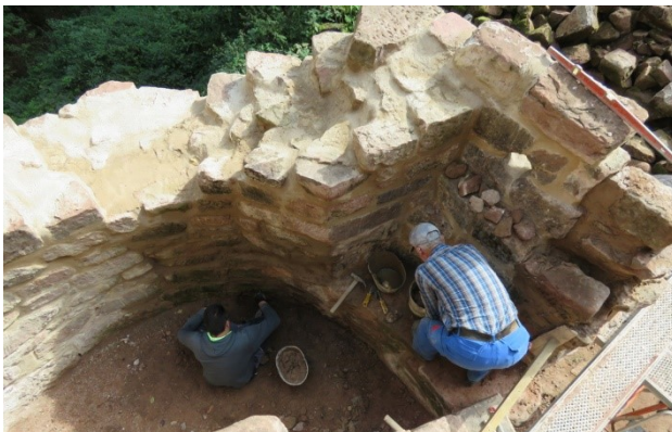
Les joints des dernières pierres posées à côté de la bouche à feu seront effectués l'an prochain.
