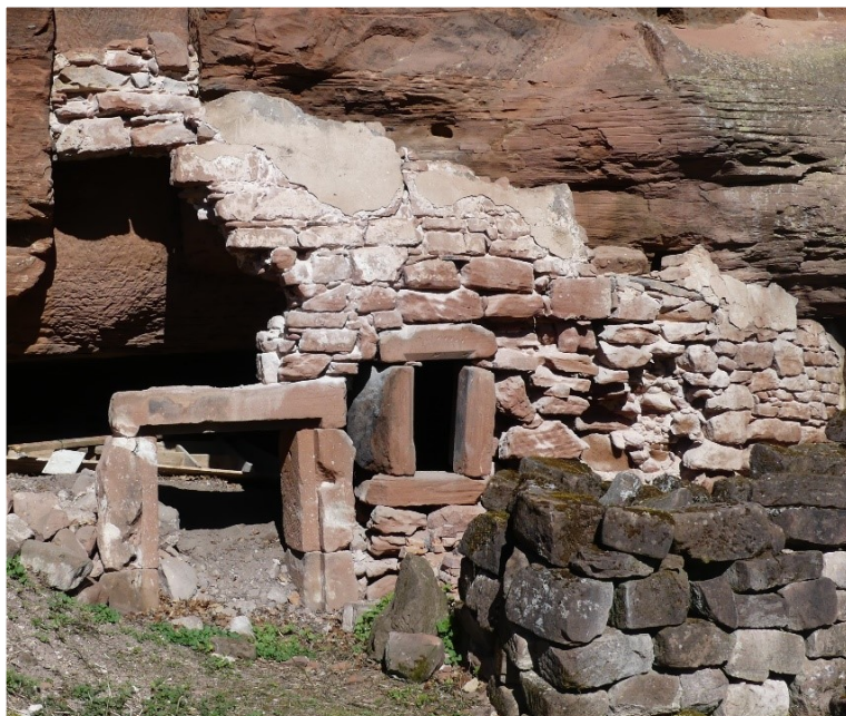
Ci-dessus en mars 2025 avant les travaux
