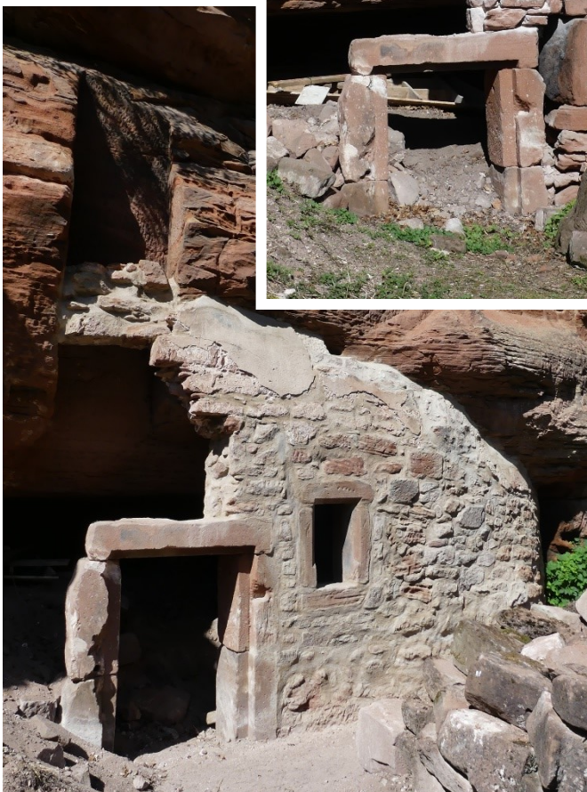
Ci-contre, en septembre 2025 après les travaux
