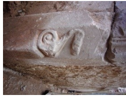
montant droit de la porte du logis avec un gond encore en place en bas à gauche
