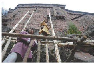
Pascal en haut, construit en échafaudage uniquement en bois. PHOTO OUI - FRANCE 3 TARN
