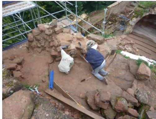
Jointoyage du mur qui fait l'angle au Logis Nord
