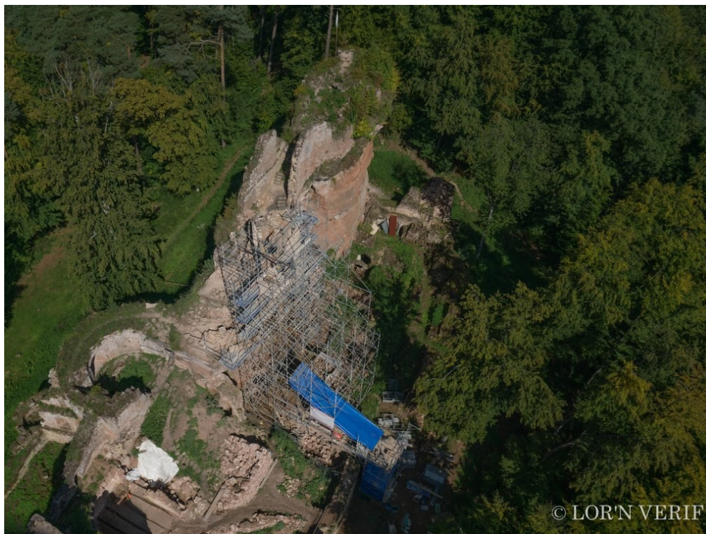
Photo prise par l'entreprise Entrepose
