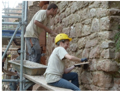
Jointoyage du mur sous le logis Nord
