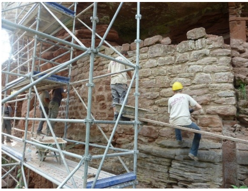
Jointoyage du mur sous le logis Nord
