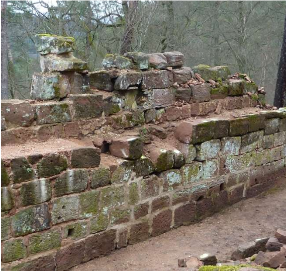
Comblement des trous, remontage de deux blocs déposés en 2018 et d'un qui manquait (photos de mars et novembre 2019).
