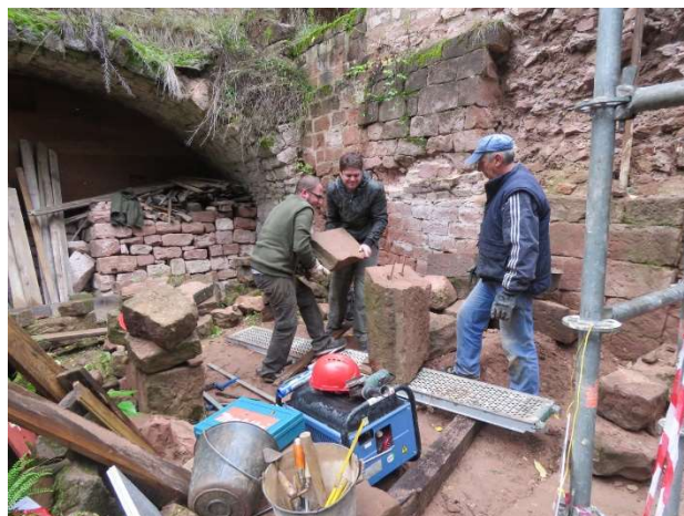
Essai pour voir si les deux blocs s'unissent correctement.
