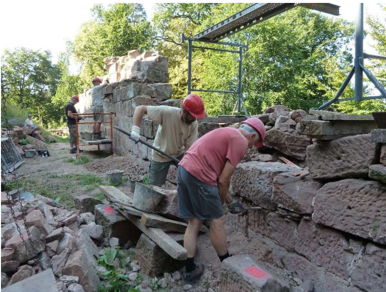
Rangées de blocs de la courtine ouest avant dépose et repose.
