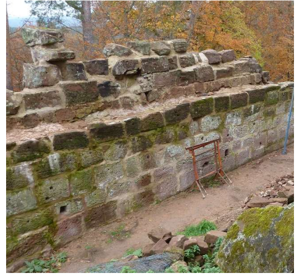
Comblement des trous, remontage de deux blocs déposés en 2018 et d'un qui manquait (photos de mars et novembre 2019).
