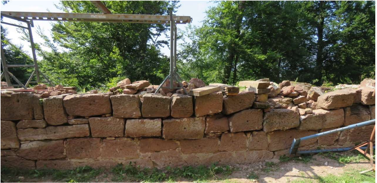
Rangées de blocs de la courtine ouest avant dépose et repose.
