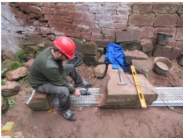
Perçage des trous.
