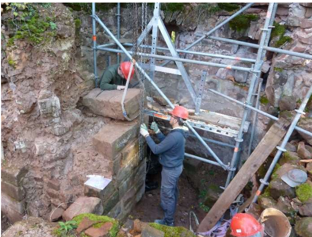
Positionnement de la pierre à bosse sur le mur.
