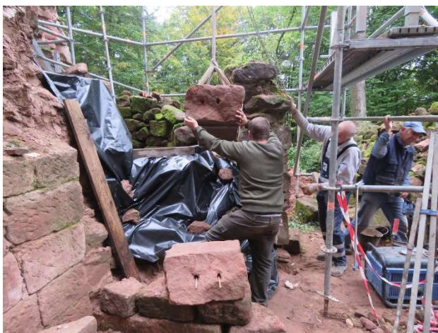
Déplacement des blocs dans la tour.
