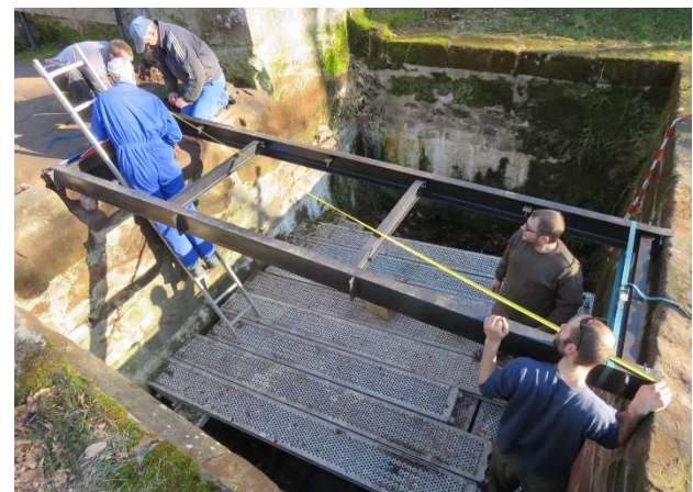
Positionnement de la nouvelle passerelle.
