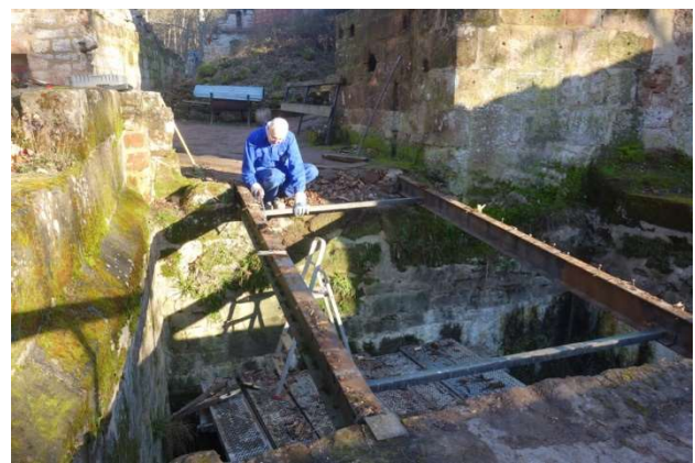
Démontage de l'ancienne passerelle qui avait été installée par notre association en 2010.
