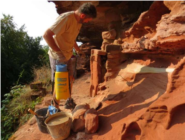
Humidification du grès avant application du mortier.
