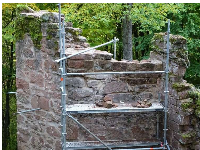
Etat à la fin de la dernière journée de maçonnerie de l'année.
