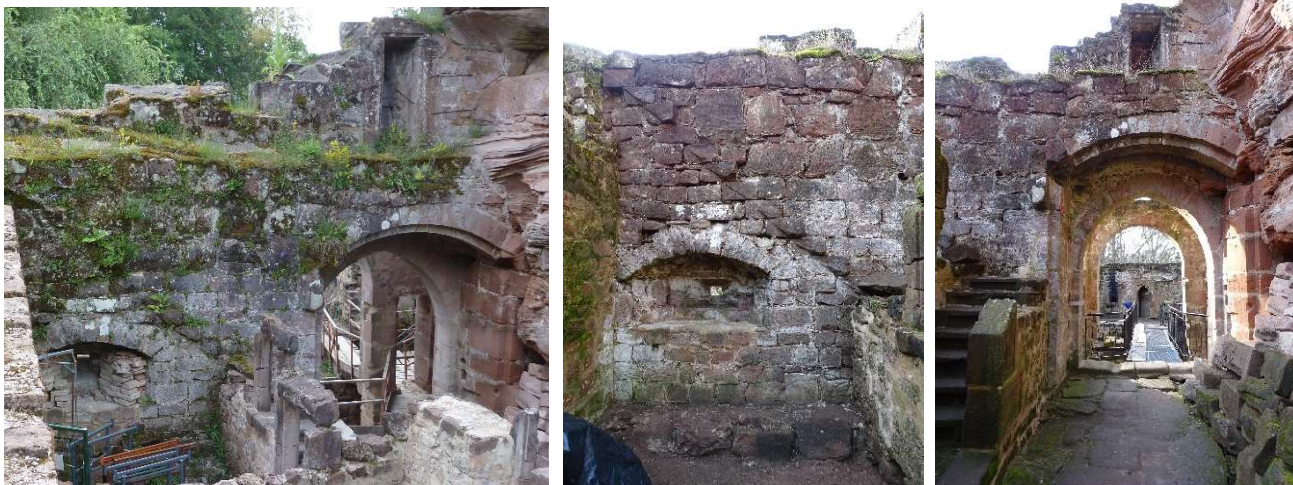
Avant les travaux en novembre 2019 et après nettoyage du mur.
