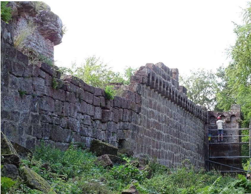
Le tronçon de mur à déposer et à remonter est bien visible sur la photo ci-dessus.
