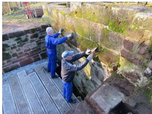
Brossage des murs de la fosse.
