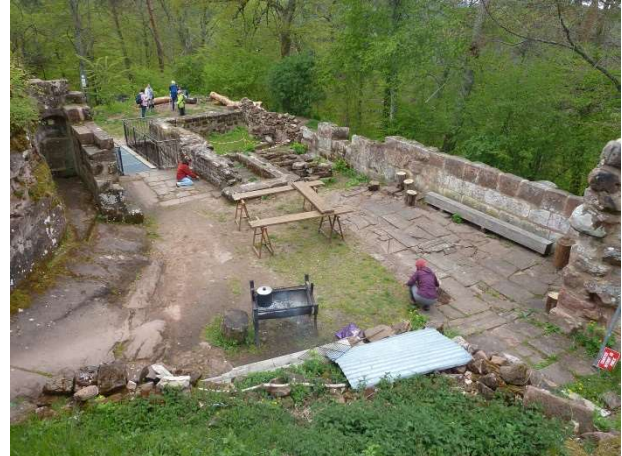
Nettoyage des dallages
