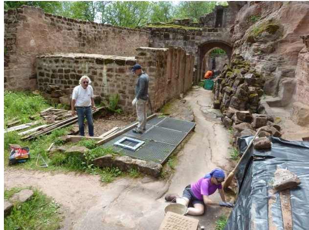
Démontage du plancher au-dessus du puits et désherbage (S11)
