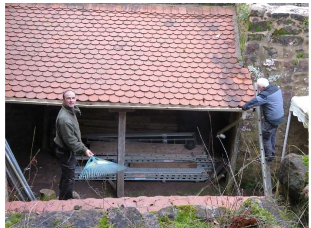
Nettoyage de la gouttière et des toitures des appentis.
