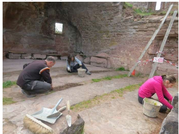
Désherbage du sol de la voûte
