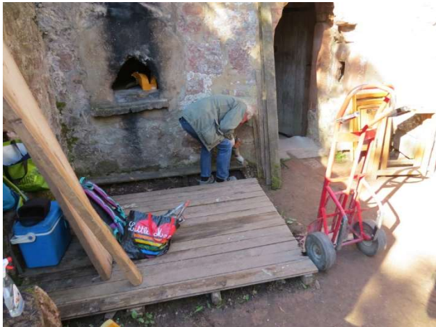
Réparation du plancher devant le bastion (S3)
