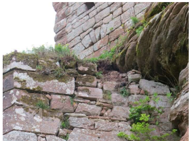
Dépose des pierres du S14 donnant sur la basse-cour ouest.
