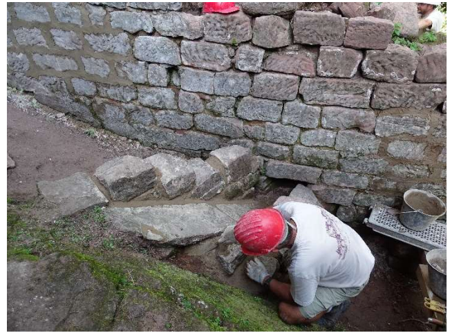
Le canal d'évacuation dans la fausse-braie.
