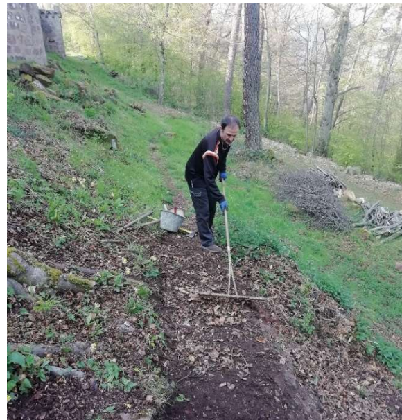
Réfection du chemin ouest (S26)
