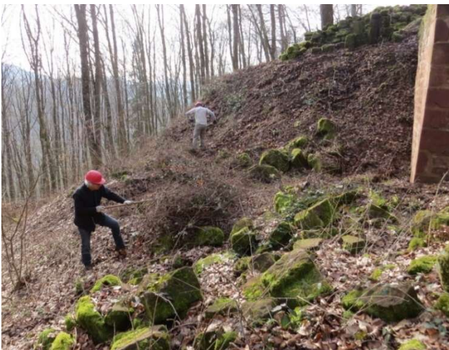
Nettoyage sous la tour octogonale en S1.
