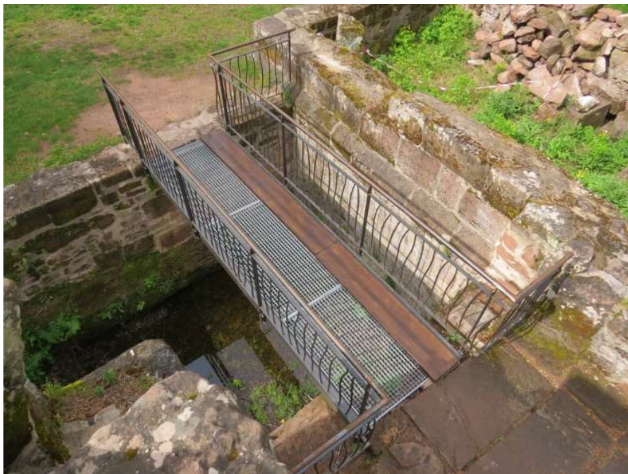
Passerelle du S2.
