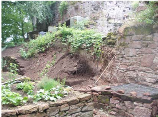
Mur barbacane sud-est, état été 2004
