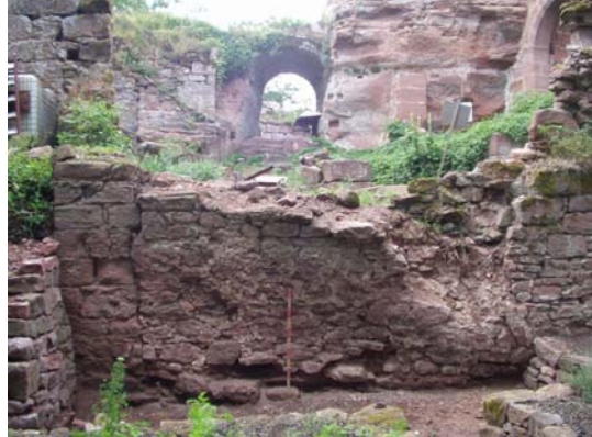
Mur barbacane sud-est, état juillet 2005
