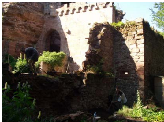
Dépose-repose de la partie gauche
