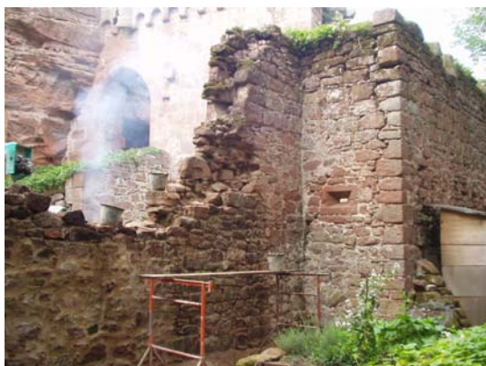
En cours de remontage
