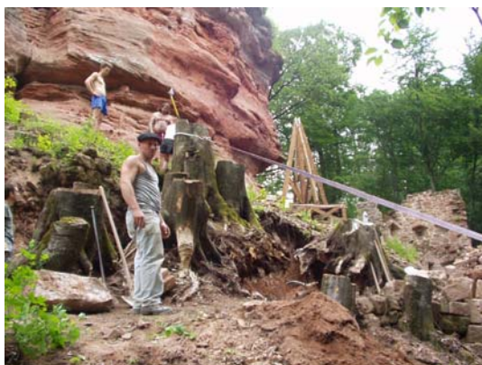
Rempart est, état juin 2005
