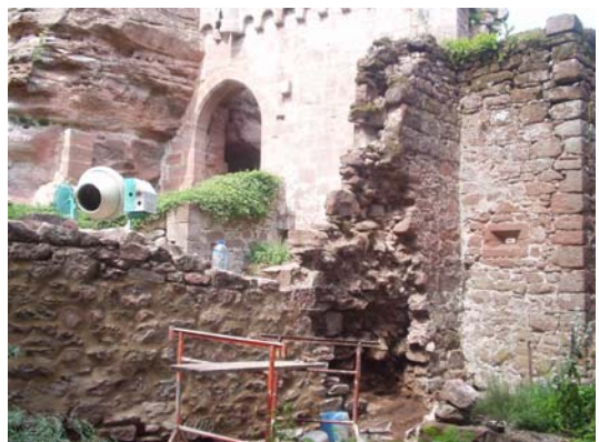
Dépose-repose de la partie droite
