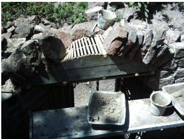
Coffrage pour l'arrière-voussure
