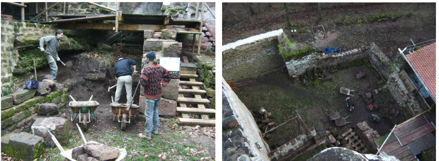
Dégagement de la terre à côté du pilier par Jacques Bruderer, Thomas Becht et David Kontomichos et vue de dessus du secteur 3
