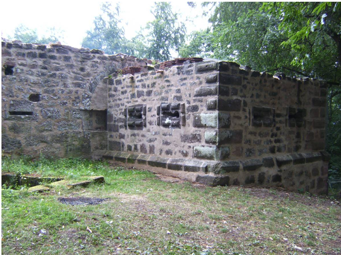
Bastion Sud-Est après travaux
