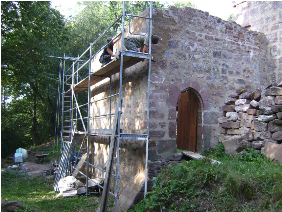
Jointoiement du mur d'enceinte, Gaëtan Nullans et Jacques Bruderer
