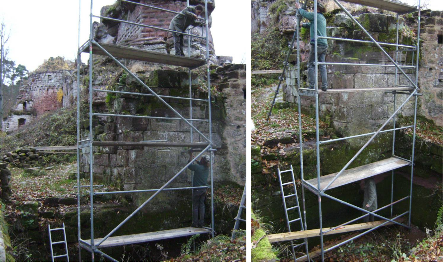
Montage de l'échafaudage dans le fossé d'entrée du château, David Kontomichos et Jacques Bruderer
