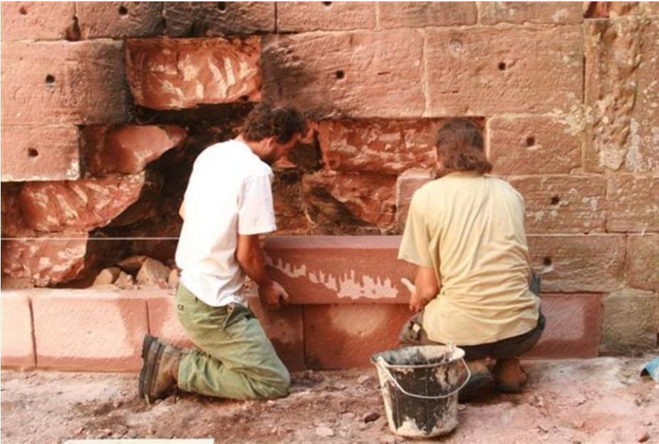
Mise en place de pierres de parement par Jacques Bruderer et Emmanuel Schneider
