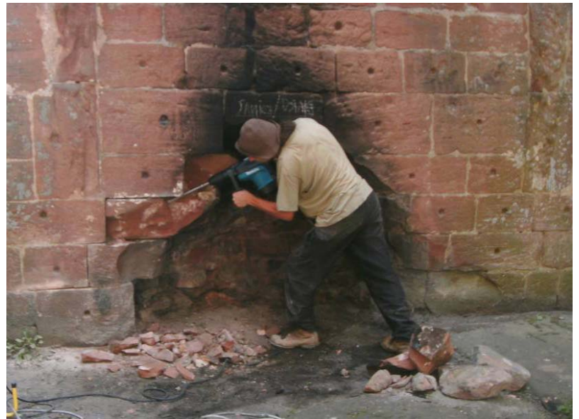
Jacques Bruderer en train de refouiller les blocs détériorés
