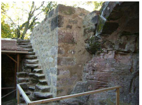
Mur consolidé et jointoyé
