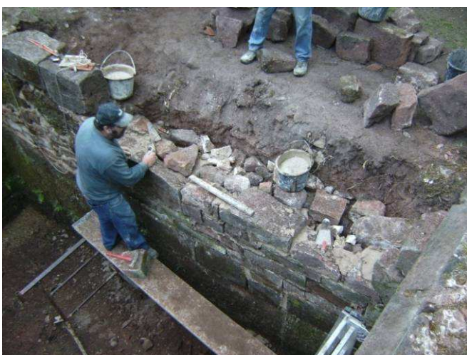
Patrick en train de maçonner la paroi Sud du fossé.
