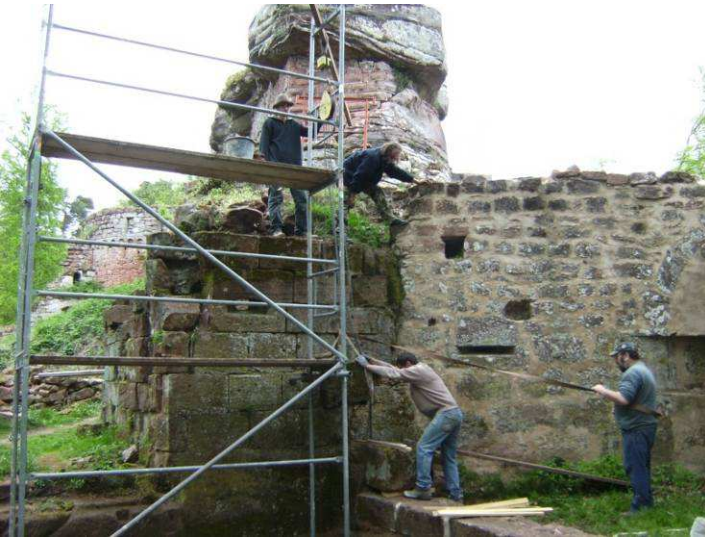
Dépose du mur à l'aplomb du fossé
