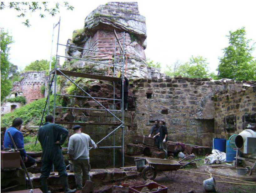
Dépose du mur à l'aplomb du fossé
