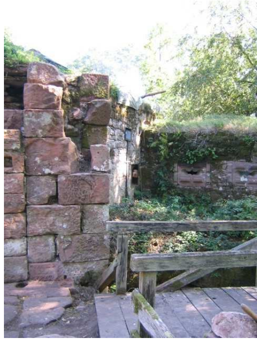
Mur à l'aplomb du fossé (2003)
