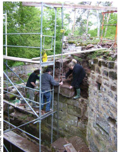
Dépose du mur à l'aplomb du fossé
