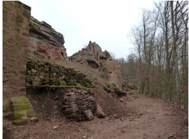
Elargissement du chemin côté Est
