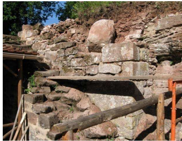
Pendant la consolidation du mur
