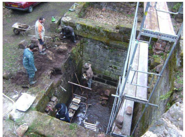
Maçonnerie de la paroi Sud du fossé, Patrick, Alain, Guilhem et Jacques
