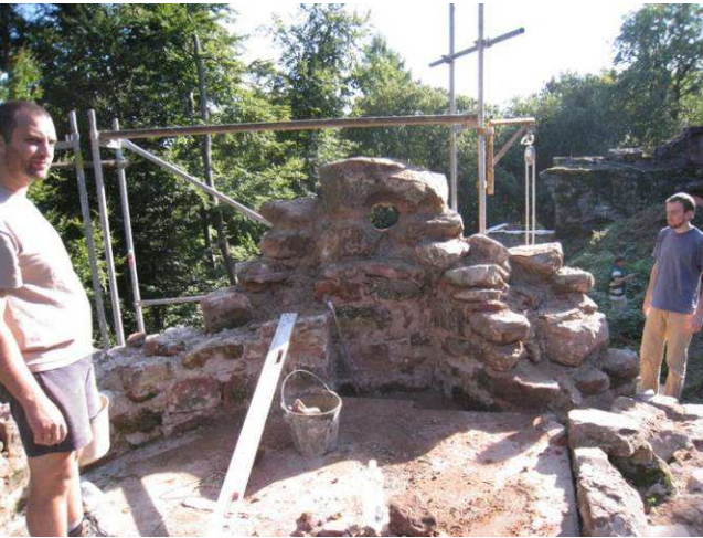
Bouche à feu Sud de la tour semi-circulaire, Guilhem et Cyprien
