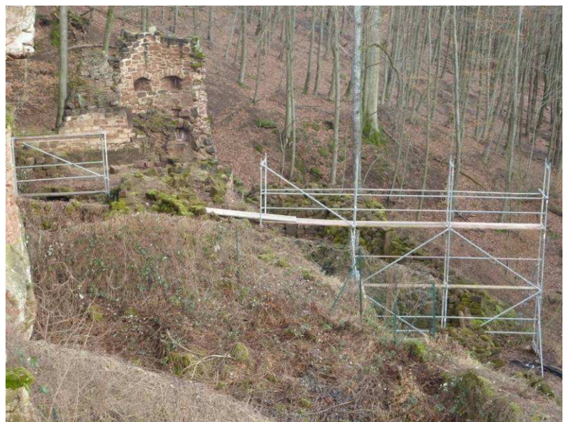
Echafaudage pour l'évacuation des gravats
