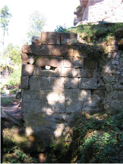
Mur à l'aplomb du fossé (2003)
