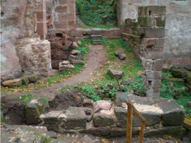
Pilier et fosse sous la porte en ogive (2006)
