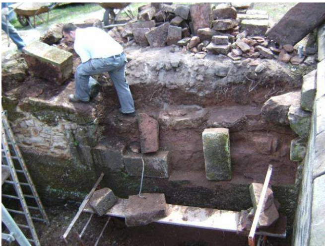
Dépose de la paroi Sud du fossé, le rocher est visible, Frédéric.
