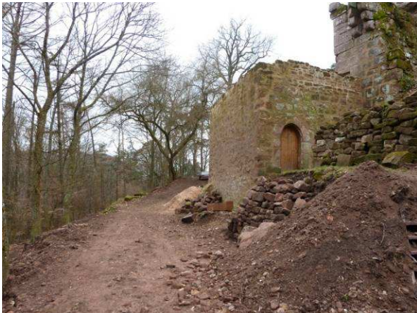
Elargissement du chemin côté Est
