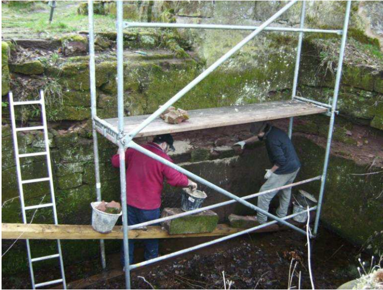
Maçonnerie du fossé, Patrick et Jacques
