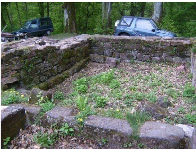
Bastion Sud-Ouest avant travaux
