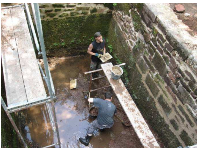
Gaëtan et Frédéric en train de nettoyer et jointoyer le fossé.
