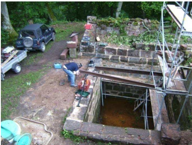
Mise en place de la passerelle, Patrick.
