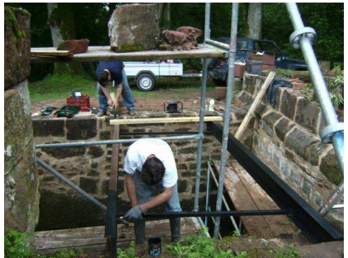
Mise en peinture des poutres de la passerelle, Patrick et Alain.
