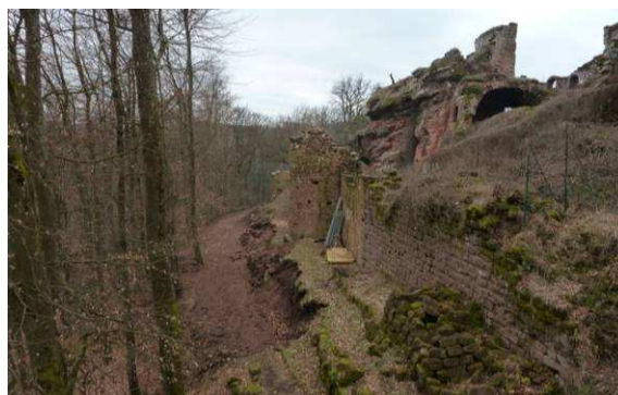
Elargissement du chemin côté Est
