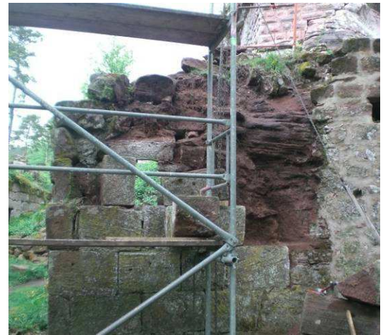
Dépose du mur à l'aplomb du fossé
