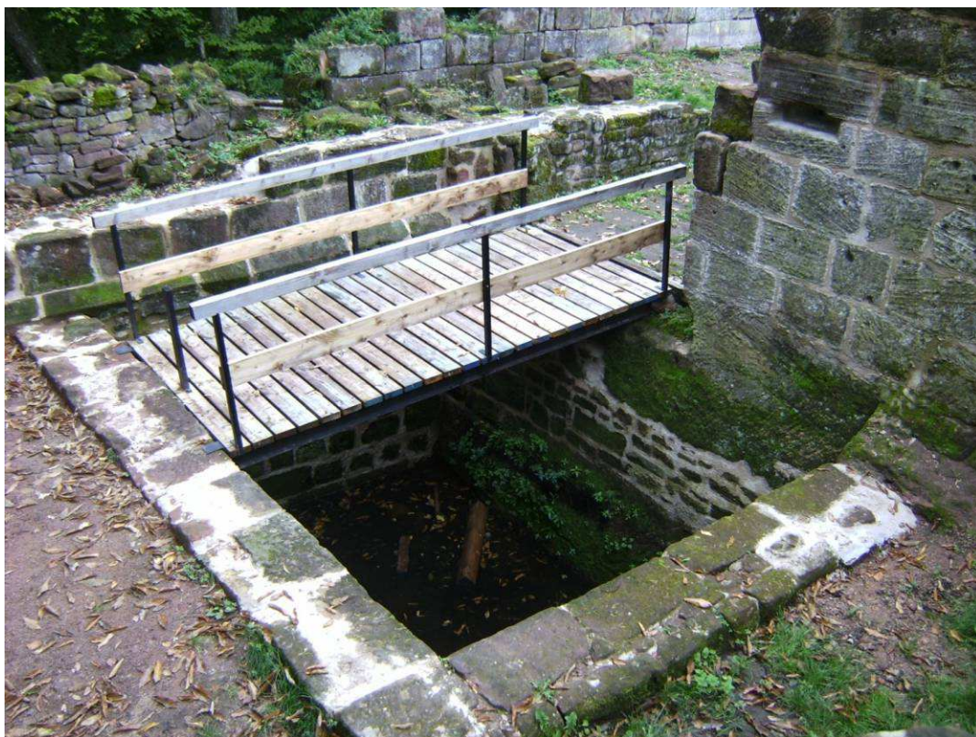
Fossé d'entrée et nouvelle passerelle
