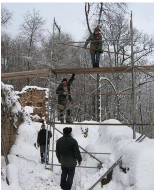
Réalisation de l'échafaudage, Frédéric, Patrick, Thomas et Jacques
