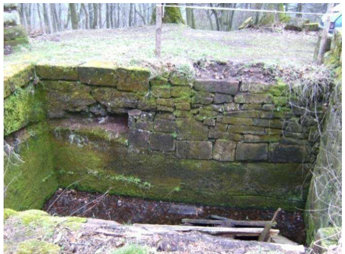
Paroi Sud du fossé (2008)
