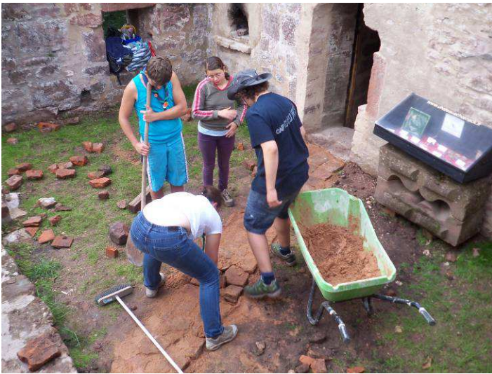
Réalisation d'un chemin dallé devant le bastion Sud-Est
