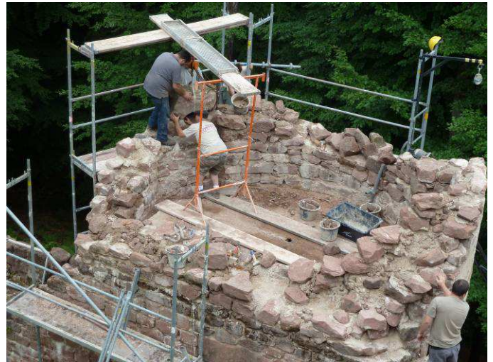
Pose de la bouche à feu Nord
