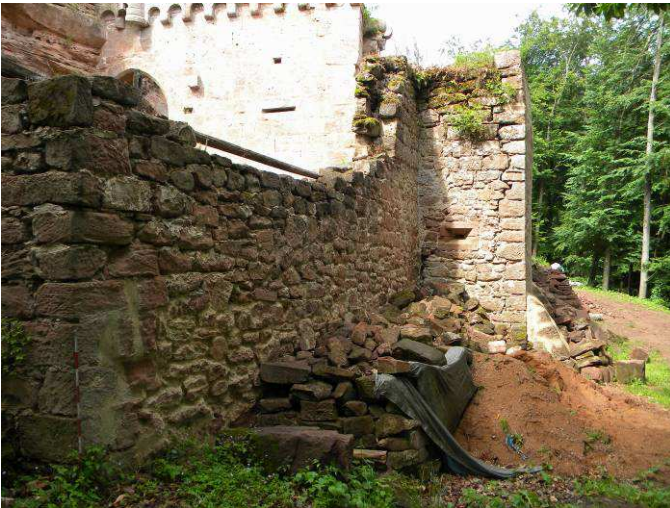
Ancienne aire de stockage des pierres
