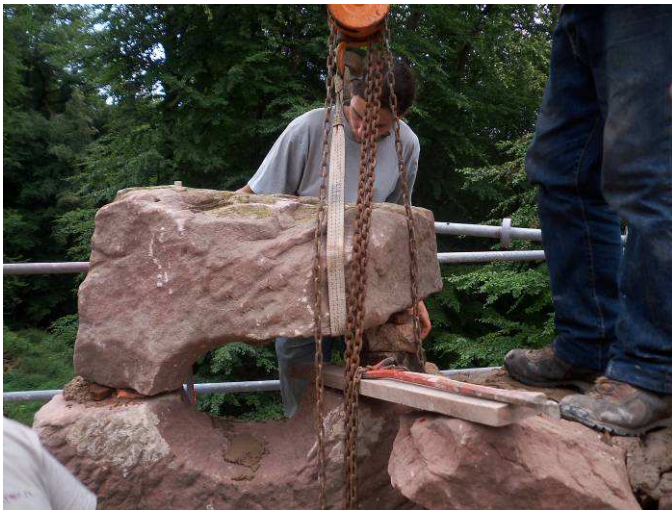
Pose de la bouche à feu Nord
