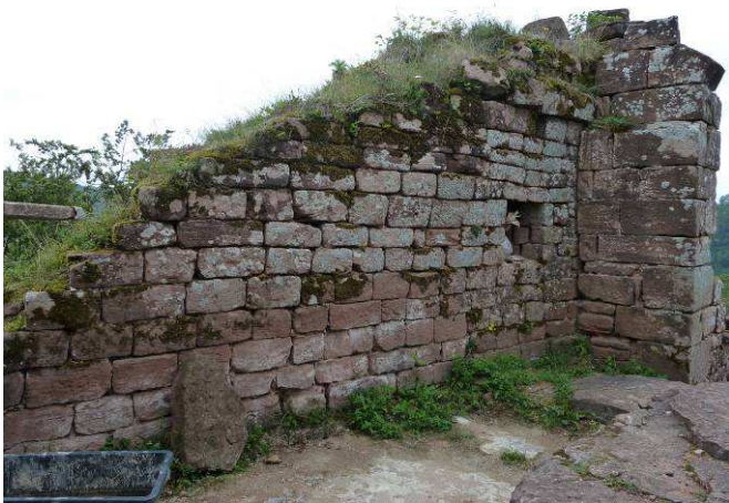
Parement du mur côté intérieur avant dépose
