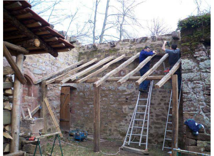
Charpente du nouvel appentis
