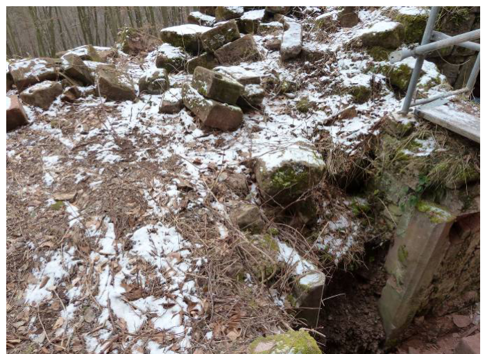
Dessus de la petite cave avec sa porte d'accès avant sondage
