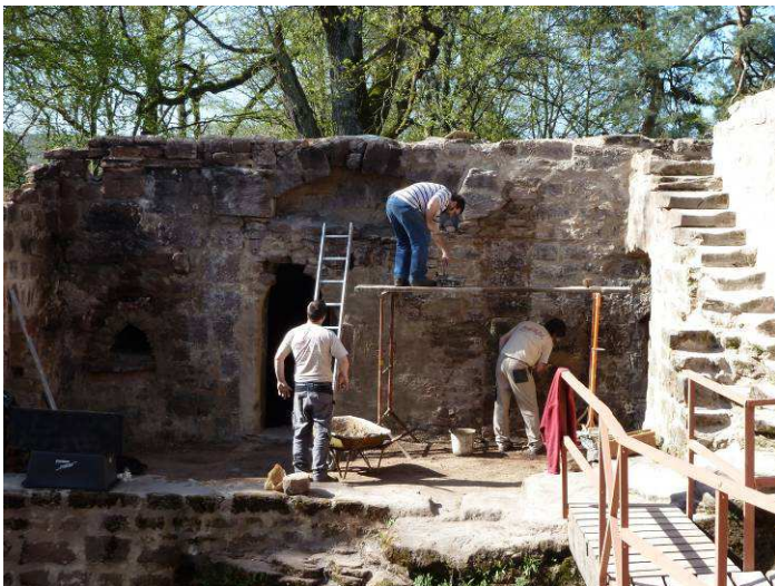
Jointoiment de la façade du bastion
