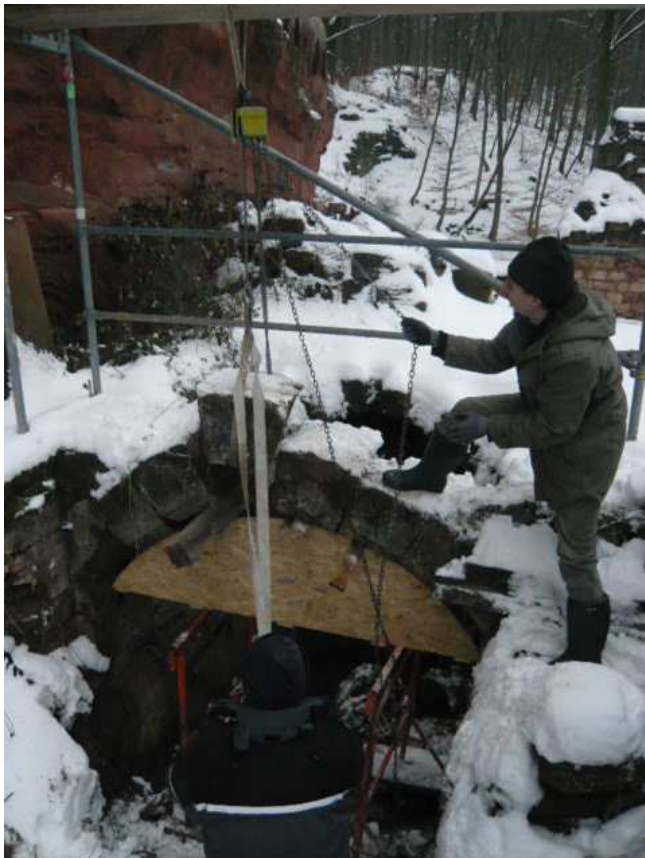
Arcade en train d'être déposée
