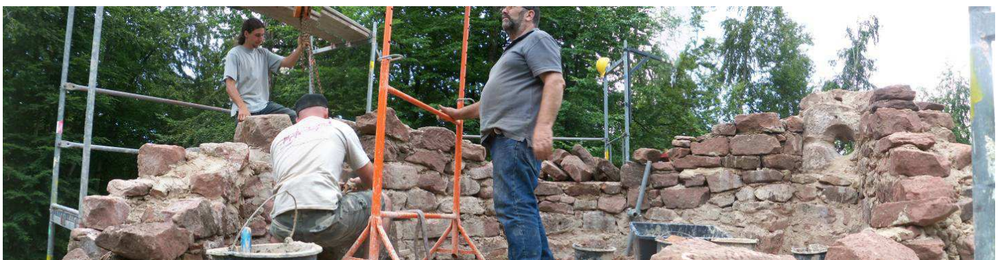
Préparation à la pose de la bouche à feu Nord
