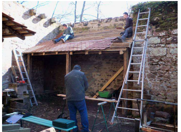
Construction du nouvel appentis
