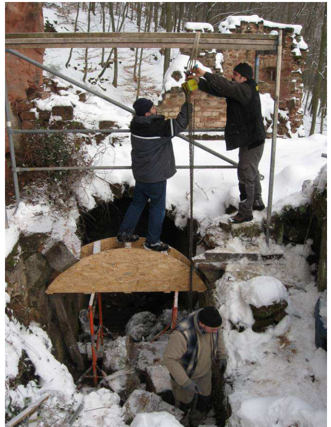
Arcade en train d'être déposée
