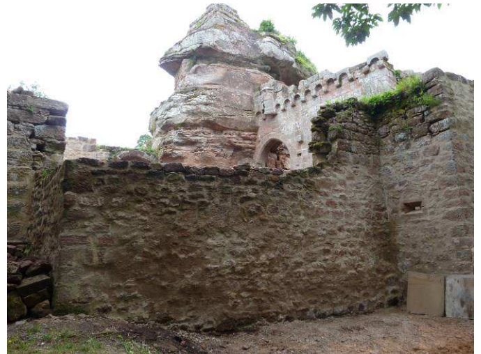
Future aire de stockage du sable
