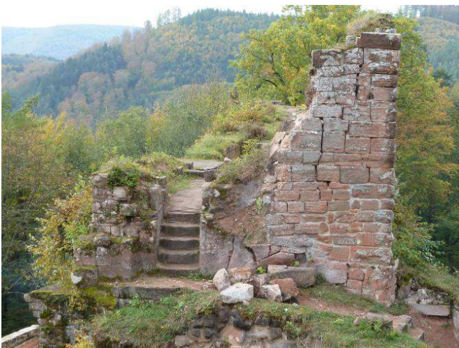
Mur Nord du rocher Sud après effondrement
