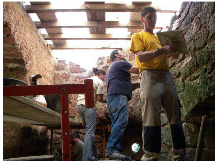
Jointoiment de l'intérieur de la tour
