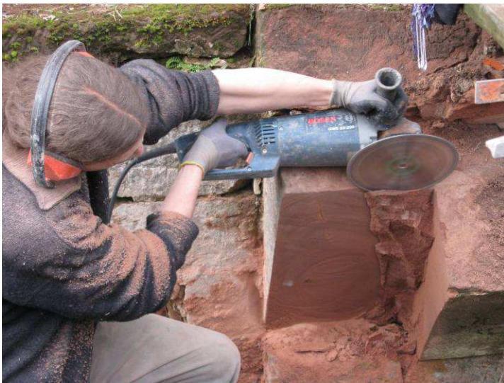
Sommier en cours de refouillement
