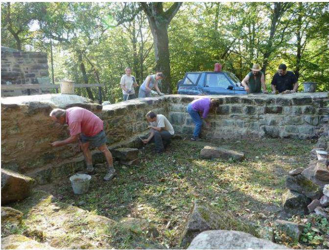
Jointoiement du bastion Sud-Ouest
