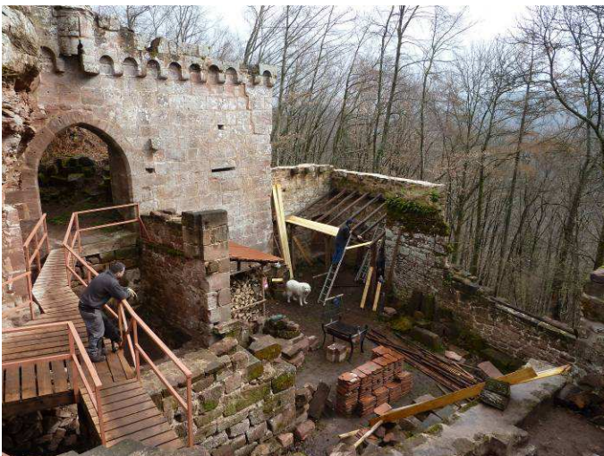
Construction du nouvel appentis
