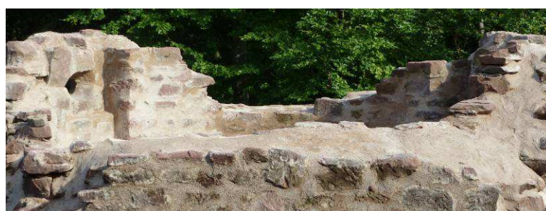
Jointoiment du deuxième étage de la tour semi-circulaire
