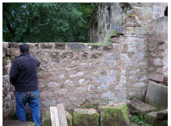
Jointolement du mur côté intérieur
