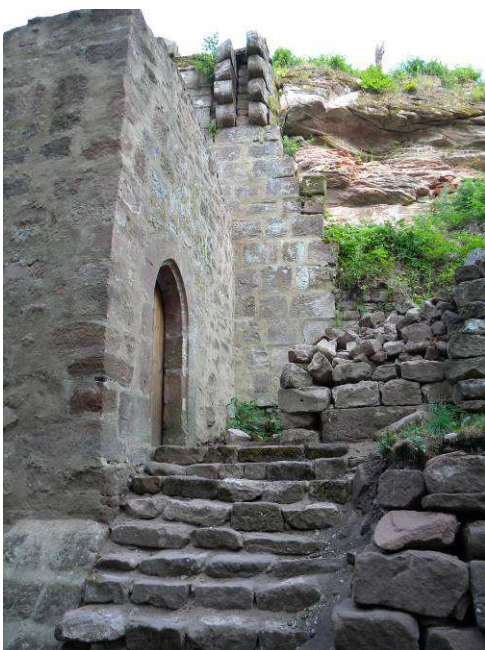
Réalisation d'un escalier en pierres sèches
