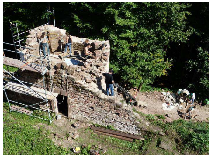
Jointoiment du deuxième étage de la tour semi-circulaire
