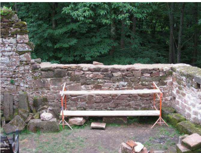
Mur côté intérieur
