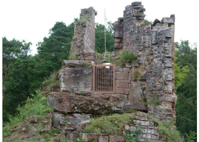
Grille interdisant l'accès au rocher Nord
