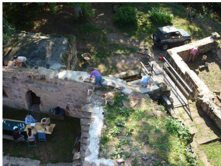
Application du mortier hydrofuge
