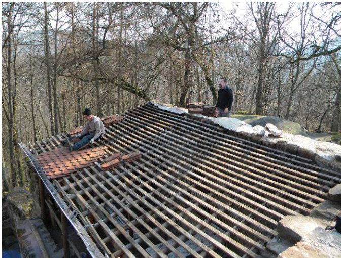
Démantèlement de l'ancien appentis
