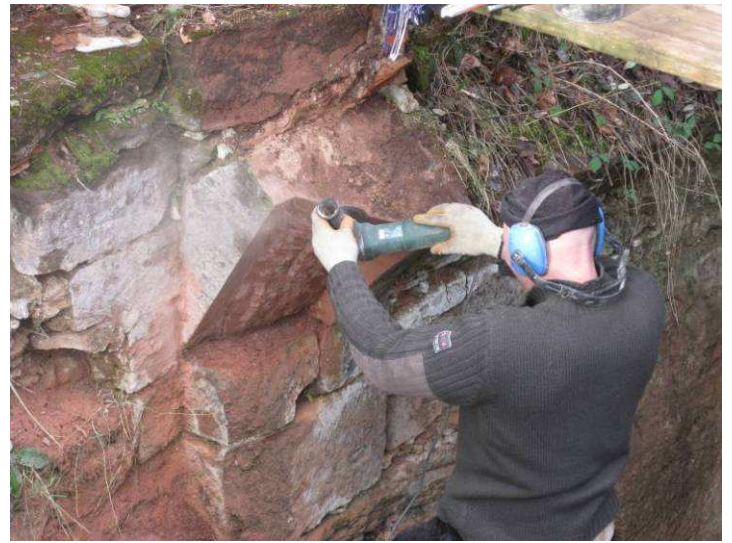
Refouillement en cours
