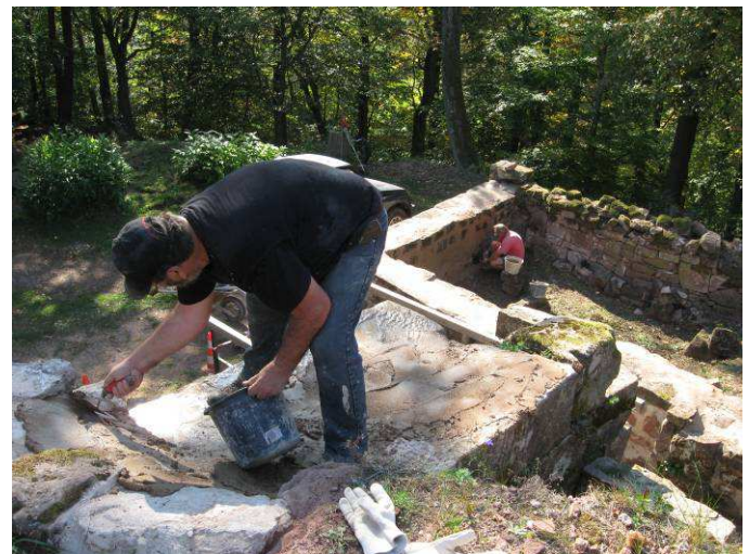
Application du mortier hydrofuge
