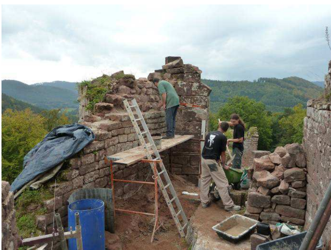
Repose du parement du mur
