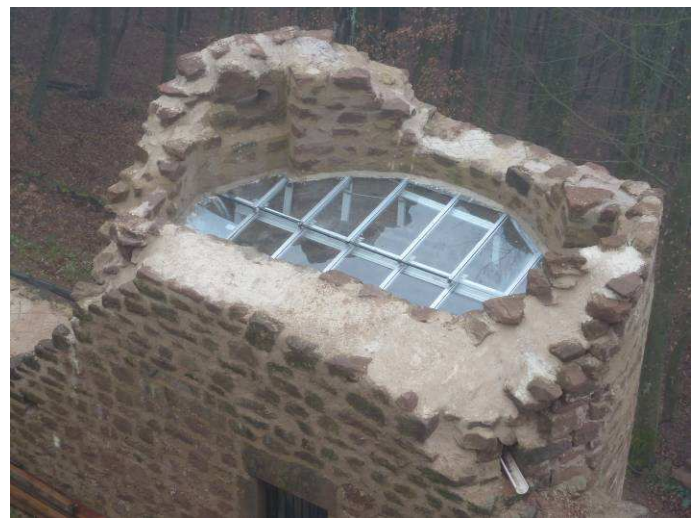
Toiture vitrée de la tour semi-circulaire
