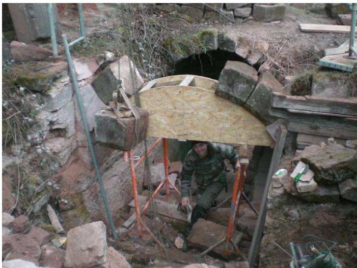
Arcade en train d'être remontée
