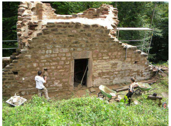
Jointoiment de la façade de la tour semi-circulaire
