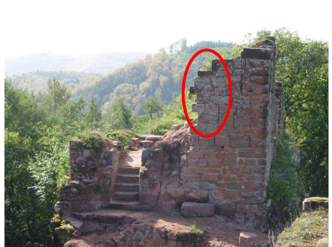
Mur Nord du rocher Sud en 2004
