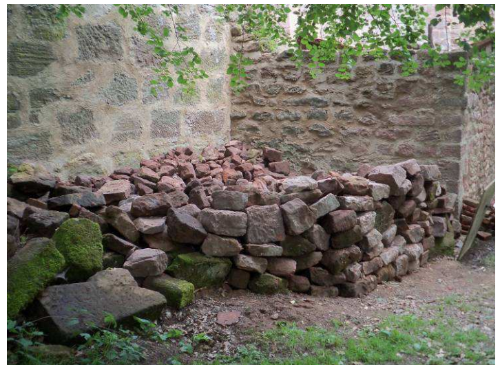
Nouvelle aire de stockage des pierres
