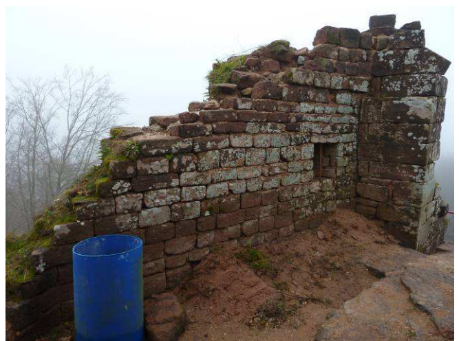
Parement du mur reposé
