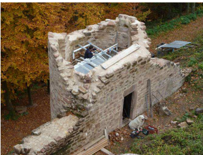
Pose par Patrick Claude de la toiture vitrée
