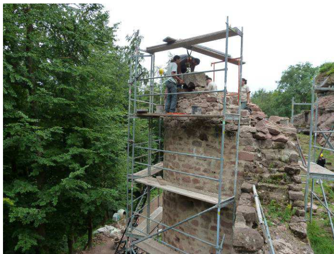
Bouche à feu Nord
