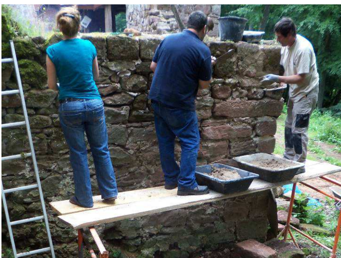
Jointoiement du mur côté extérieur
