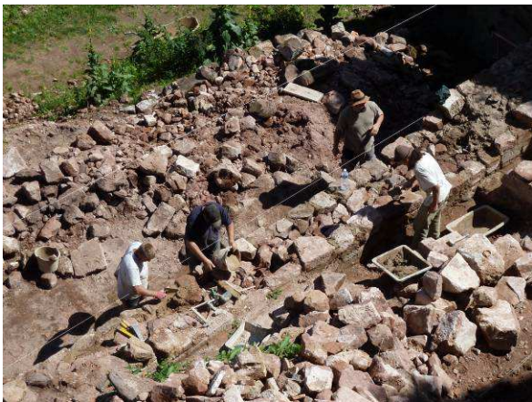
Maçonage du rempart.
