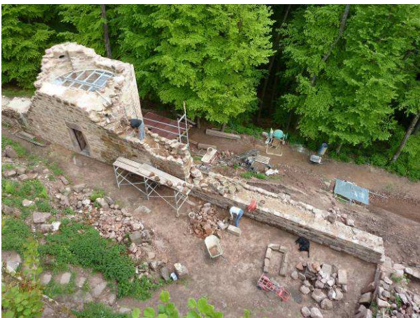
Vue de dessus du chantier.
