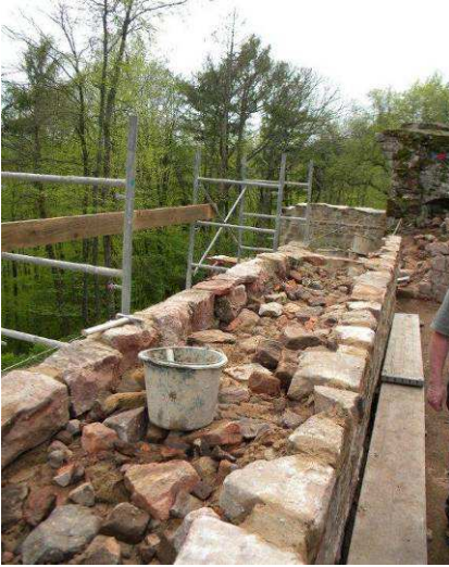
Remplissage du rempart Est.
