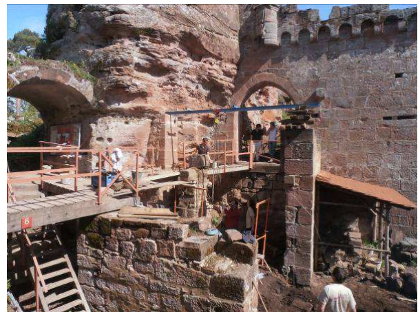
Remontage du pilier central.
