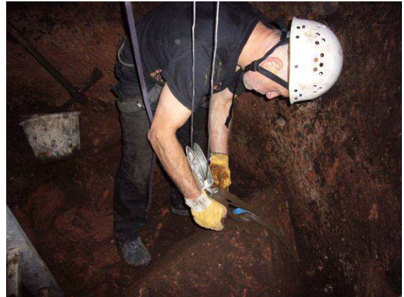
Fixation d'un bloc avant de le remonter à la surface.
