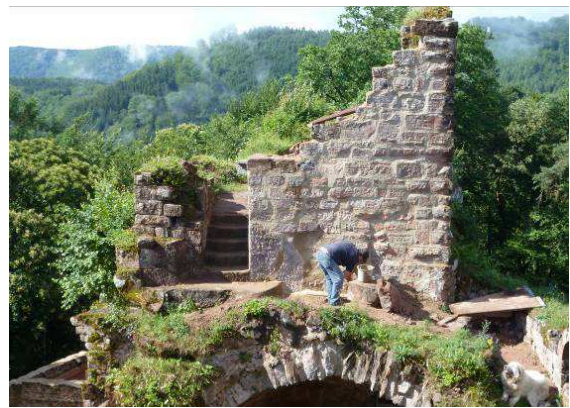
Brossage des joints du mur.
