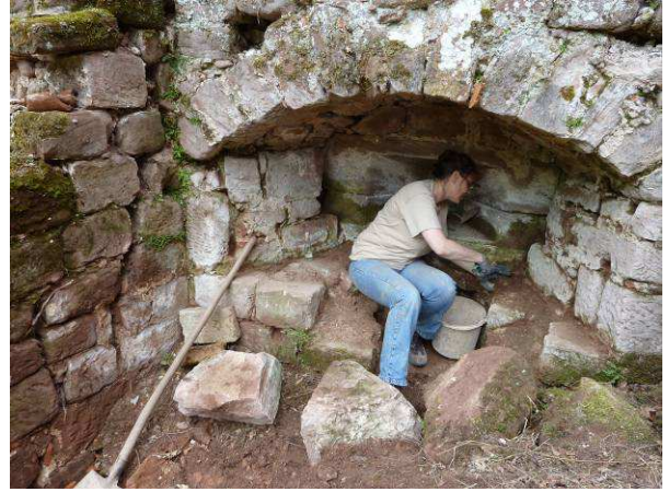
Nettoyage de la niche à bouche à feu.
