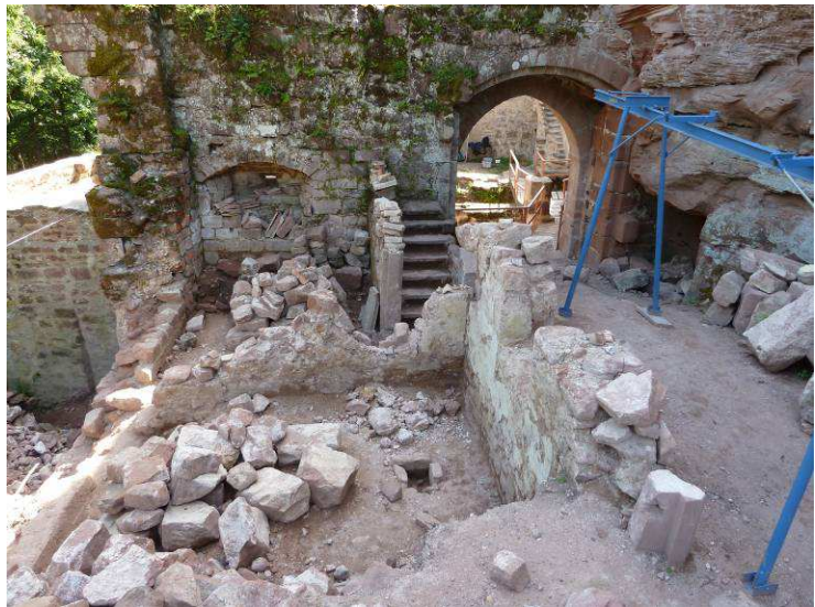
Vue sur la première pièce et une partie de la deuxième pièce.
