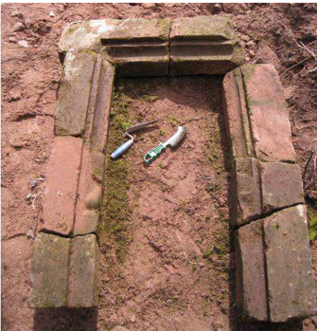
Encadrement de la fenêtre de la première pièce.
