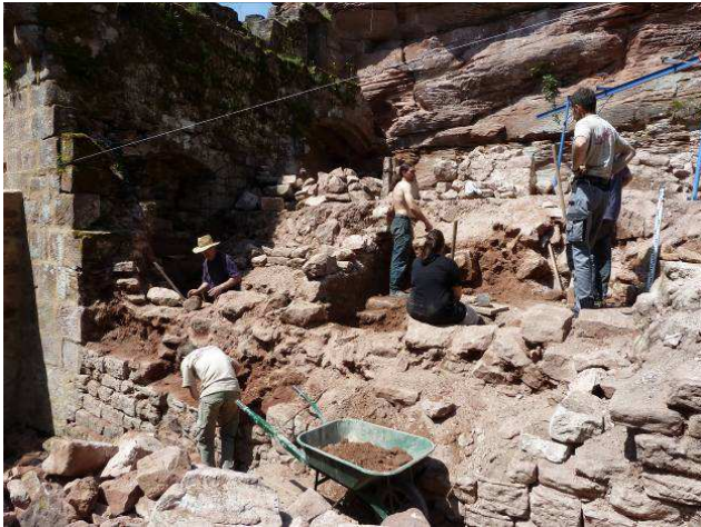
Maçonnage du rempart Est.
