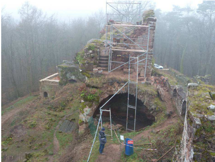
27-12-2011 : chantier du rocher Sud avant sa consolidation
