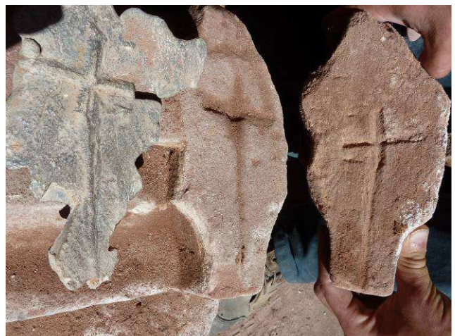
Joint entre deux pierres coulé au plomb.
