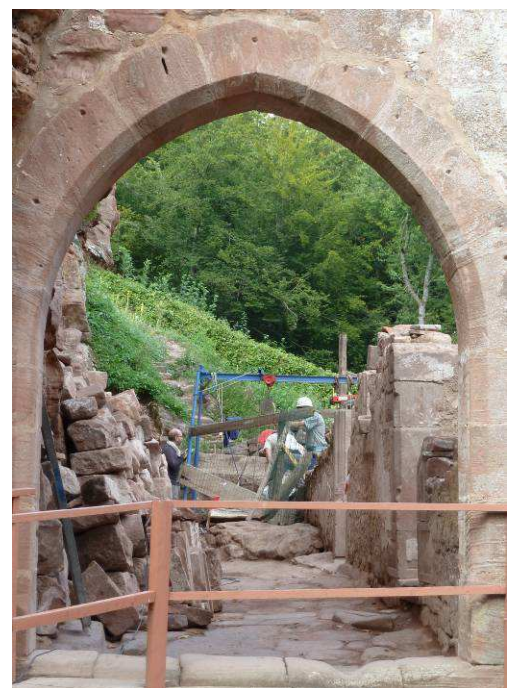
Vue sur le couloir après le dégagement de 2012.
