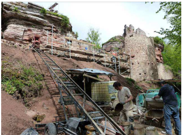
Le monte-charge qui permet d'acheminer le matériel au chantier.
