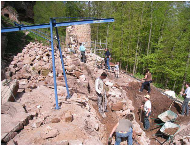
Dégagement du rempart Est.
