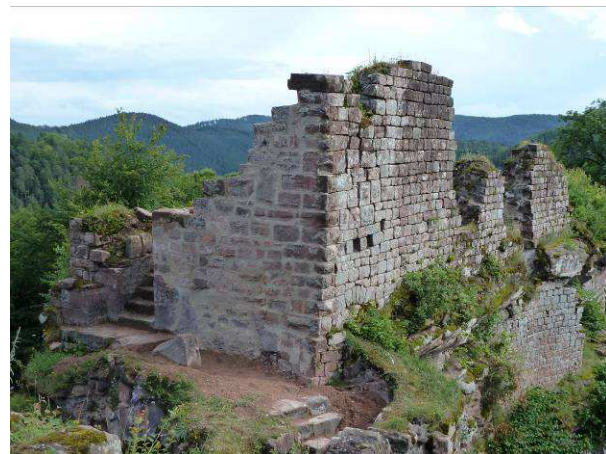
Mur consolidé, juillet 2012.
