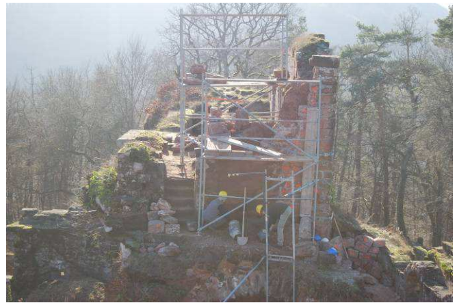
Mur du logis Sud, côté extérieur
