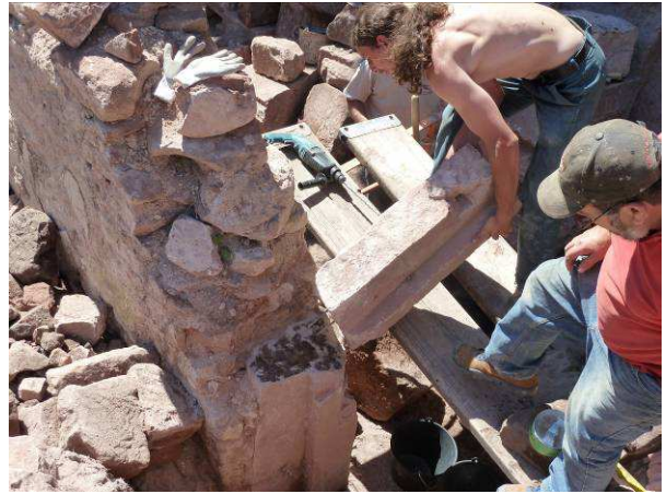
Pose d'un montant de porte de la 2 ème pièce avec colle et goujons.
