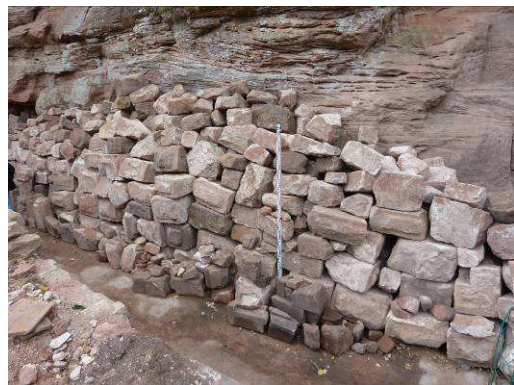
Stockage des blocs provenant du logis du rocher Sud.
