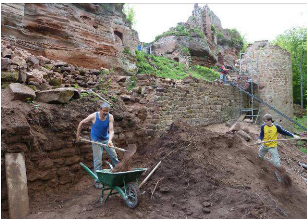
Dégagement du rempart Est.
