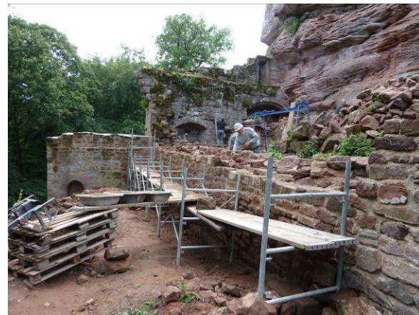
Maçonage du rempart.
