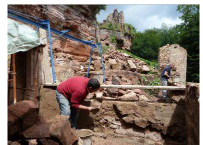
Consolidation du mur entre les 2 pièces.
