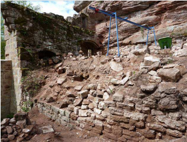
Rempart Est dégagé.
