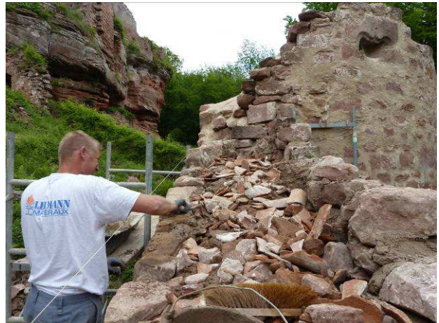
Remplissage du rempart avec des tuiles cassées trouvées en S10.
