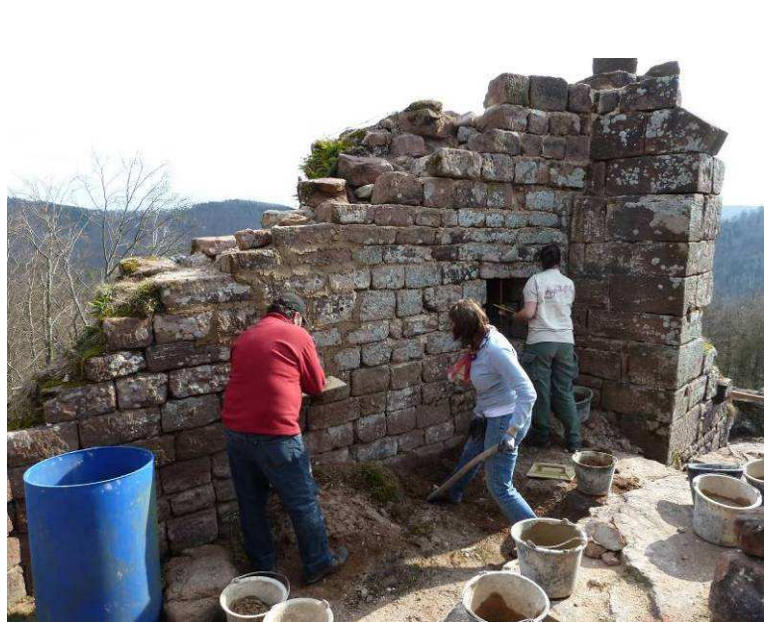
Jointoiment du mur.
