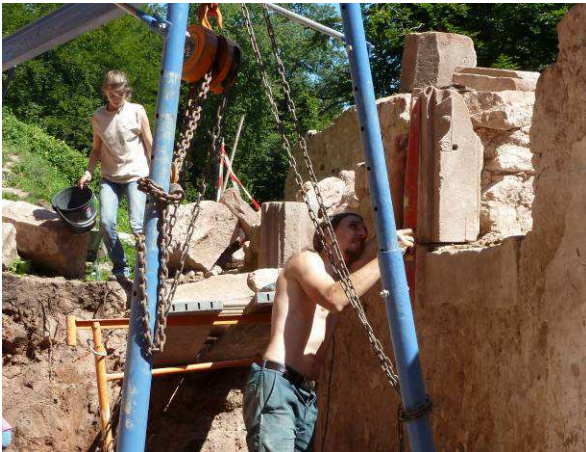
Pose d'un montant de fenêtre de la 2 ème pièce.
