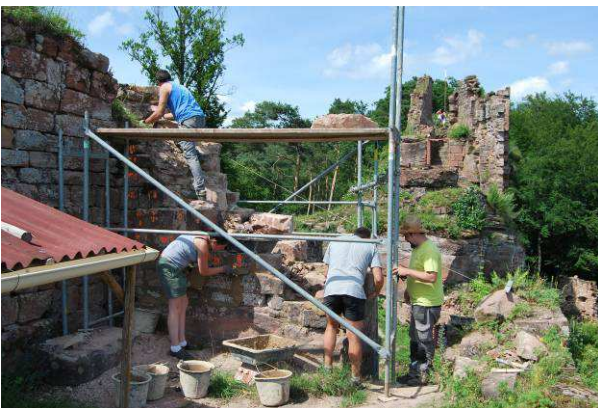
Jointoïement du mur.
