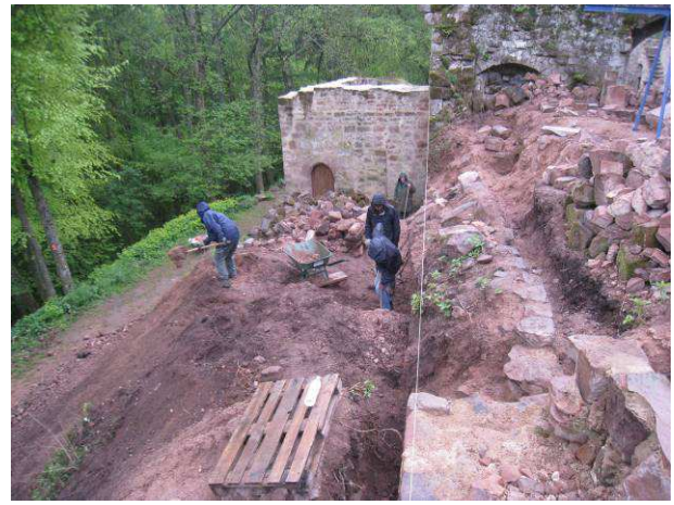
Dégagement du rempart Est.
