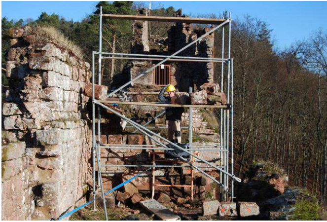
Mur du logis Sud, côté intérieur
