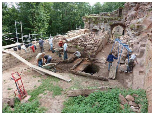
Vue sur l'ensemble du secteur autour du puits.
