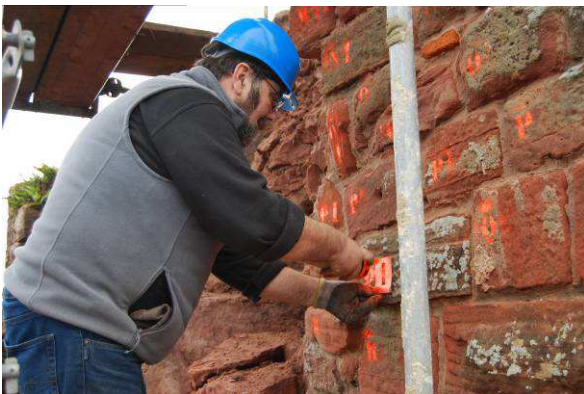
Marquage des blocs
