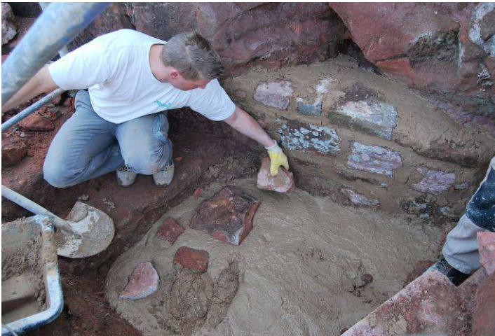
Rocaillage sur le dessus de la voûte de la pièce d'en-dessous.
