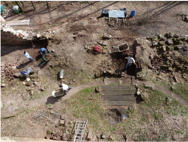
Vue de dessus de la zone autour du puits en mars 2012.
