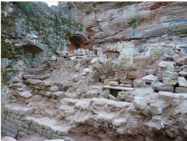
Maçonnage du rempart Est et pièces en cours de dégagement.
