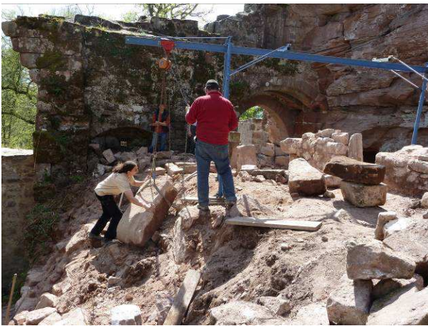
Déplacement d'un bloc à l'aide du portique.
