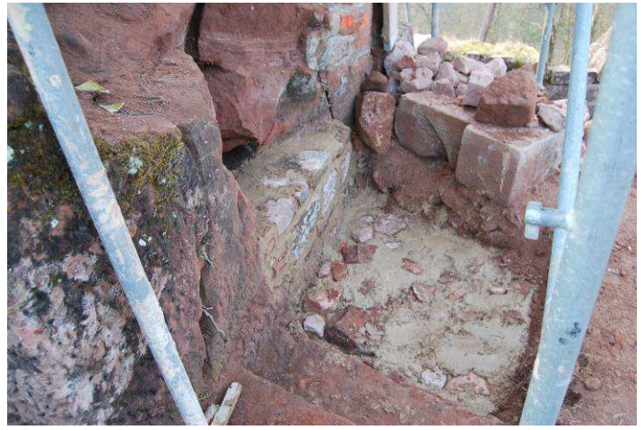
Rocaillage du dessus de la voûte et premières assises du mur.
