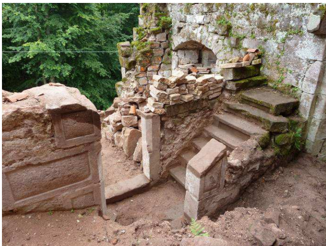
Escalier menant au chemin de ronde et la porte de la première pièce.
