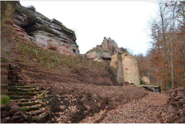
Rempart Est après dégagement.
