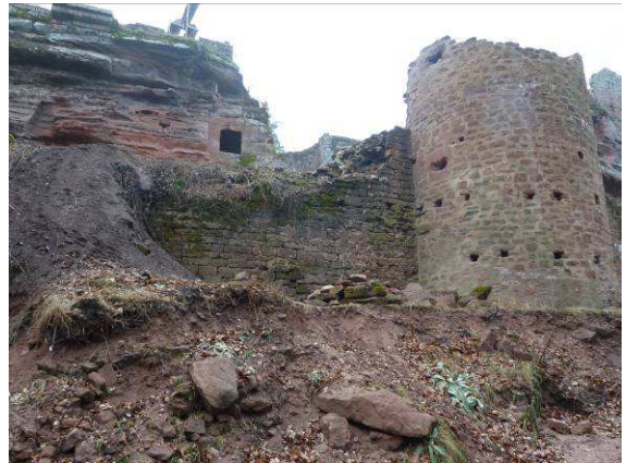
Rempart avant consolidation, février 2012.
