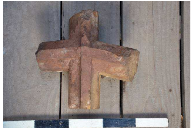
Élément de voûte de la chapelle trouvé dans le puits (croisée d'ogive).
