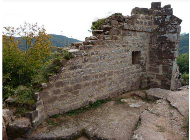
Mur du logis Nord consolidé.
