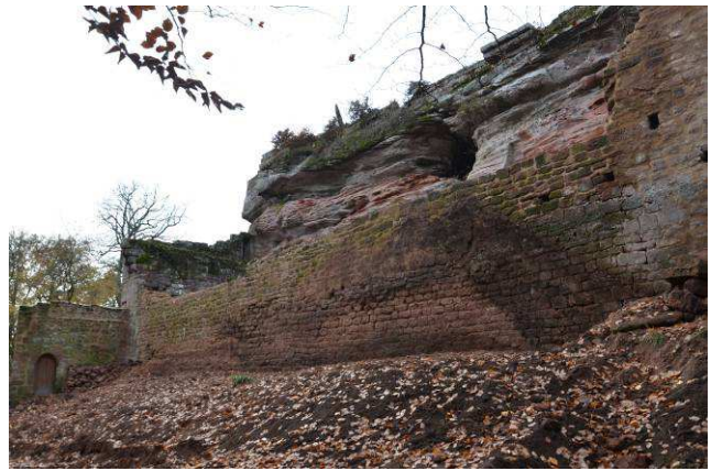
Rempart Est après dégagement.
