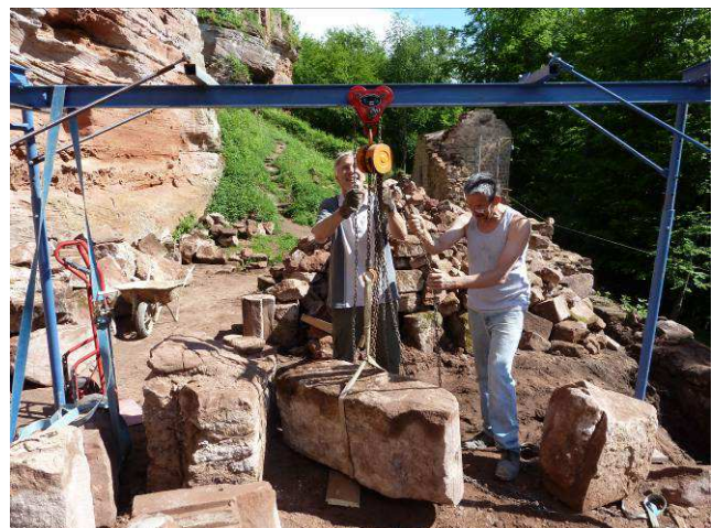
Déplacement d'un bloc à l'aide du portique.
