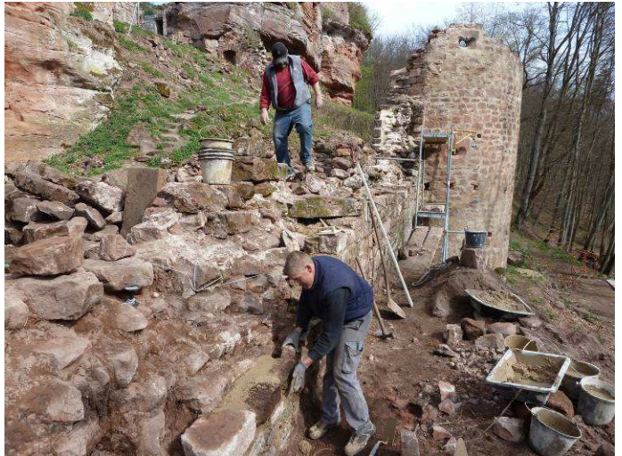
Maçonnerie des assises du rempart Est.
