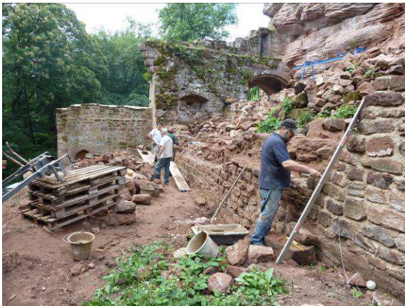
Maçonage du rempart.
