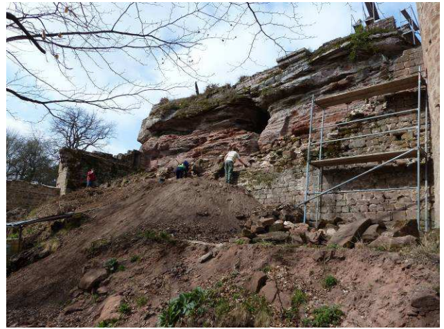
Dégagement du rempart Est du côté extérieur.
