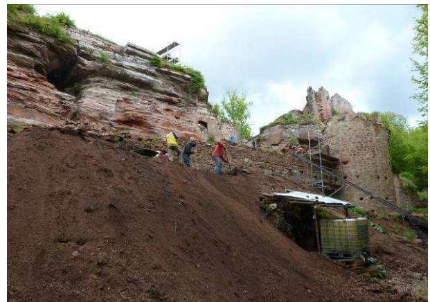
Dégagement du rempart Est.
