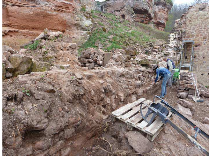
Dégagement du rempart Est.
