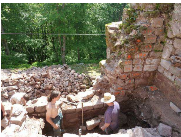
Rempart Est avec le marquage des moellons à déposer.
