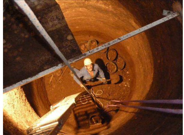
Travail au fond du puits.
