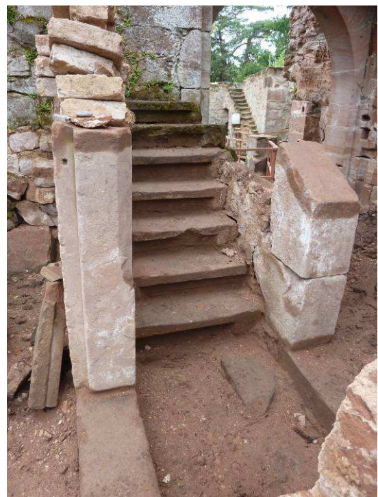
Escalier menant au chemin de ronde.
