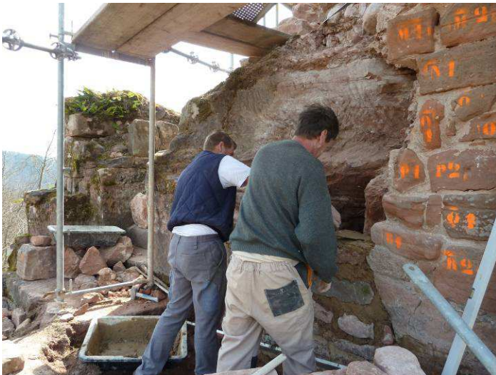
Maçonnage du mur du rocher Sud.
