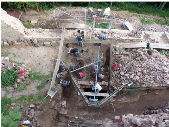
Vue de dessus du chantier autour du puits.
