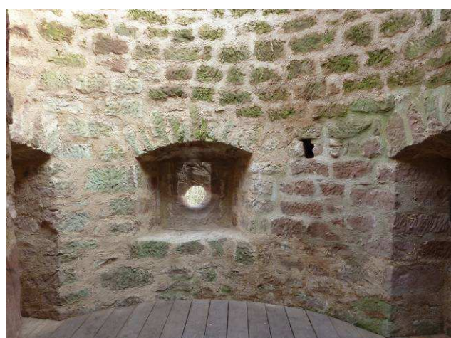
Intérieur de la tour semi-circulaire
