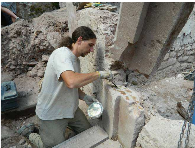
Applique de la colle pour le montant de la porte de la 1 ère pièce.
