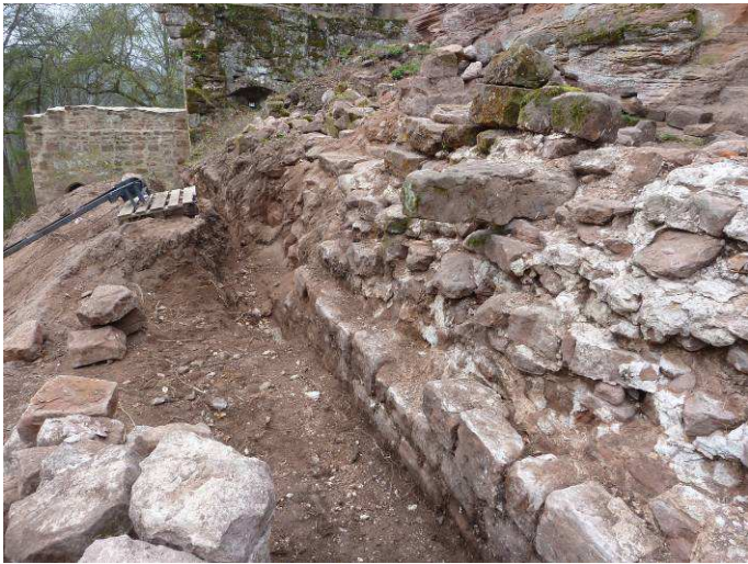
Dégagement du rempart Est.
