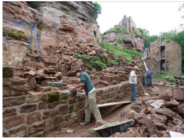
Maçonage du rempart.
