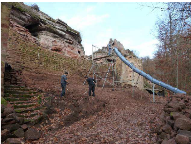
Goulottes de chantier.
