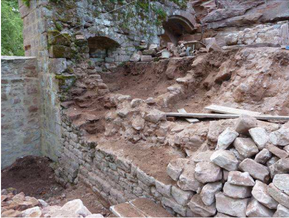
Rempart Est dégagé.
