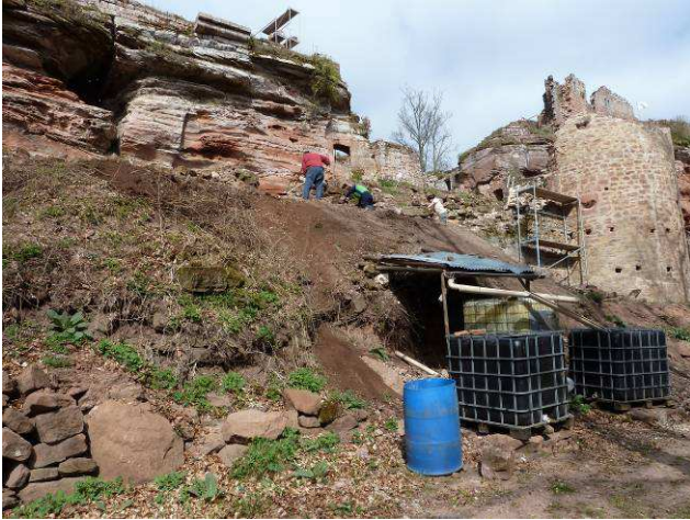
Dégagement du rempart Est du côté extérieur.
