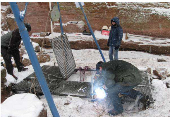
Soudage du caillebotis au-dessus du puits.
