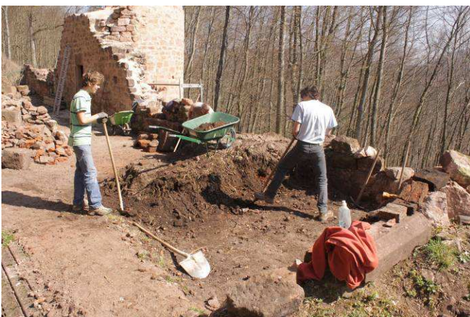
Dégagement de la basse-cour Est le long du rempart.
