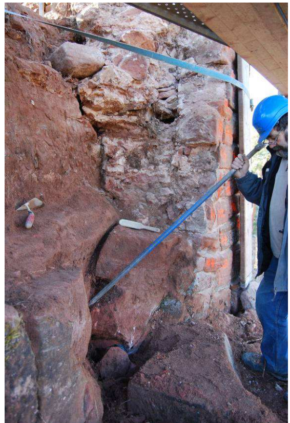
Rocher où repose le mur du logis Sud
