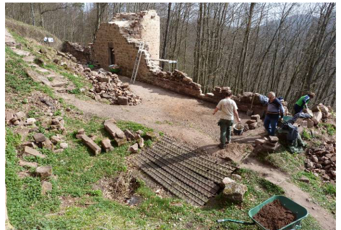
Etat du dégagement au 31-03-2012 ; arrivée au niveau du puits.
