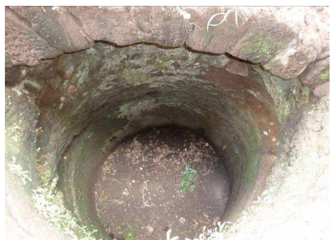
Intérieur du puits avant le début du sondage de 2012.
