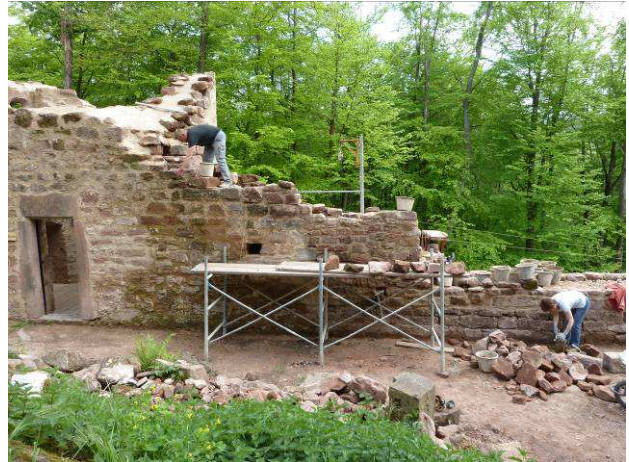
Remontage du rempart accolé à la tour.
