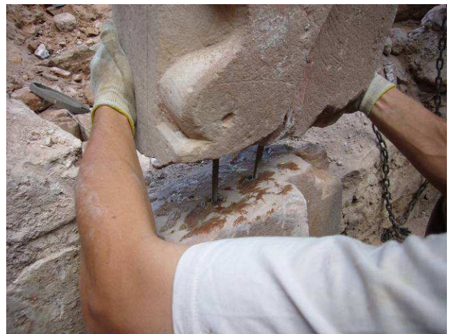
Pose du montant de la porte de la 1 ère pièce avec les goujons.
