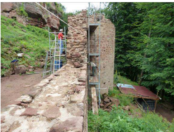
Jointoiment du rempart.
