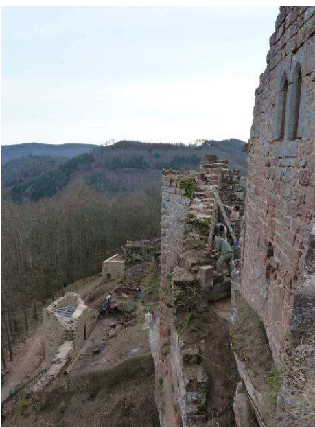
Jointoiment du mur et dégagement de la basse-cour.
