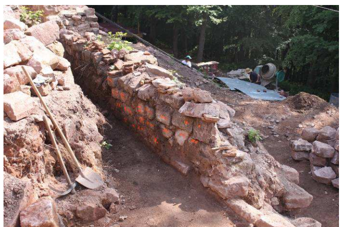
Rempart Est avec le marquage des moellons à déposer.
