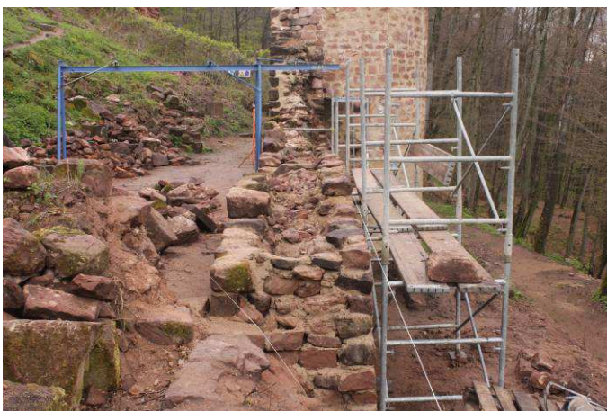
Rempart Est avec les beaux parements à l'extérieur et le remplissage entre.
