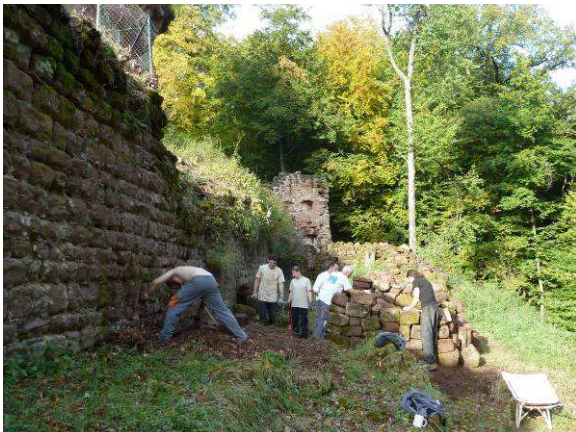
Déplacement d'un tas de pierres qui était adossé contre le mur.
