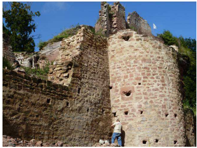
Jointoiement du rempart Est
