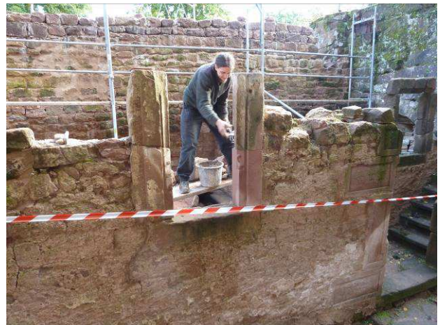
Consolidation de l'encadrement de fenêtre.
