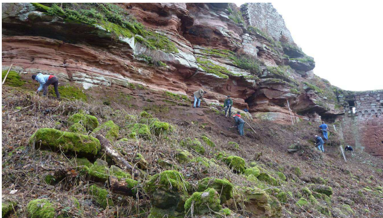
Base du rocher Nord côté Ouest.
