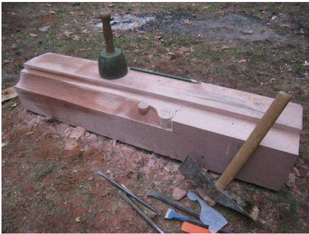
Montant de fenêtre du 2 ème local Renaissance.
