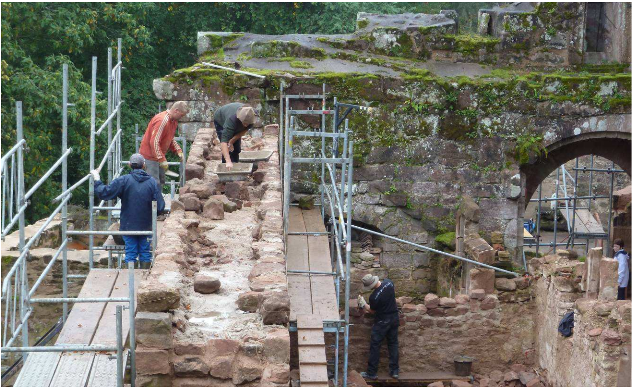
Maçonnage du rempart Est et mur de refend entre les deux locaux.
