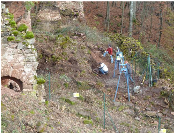
Recherche des pierres du chaînage d'angle.
