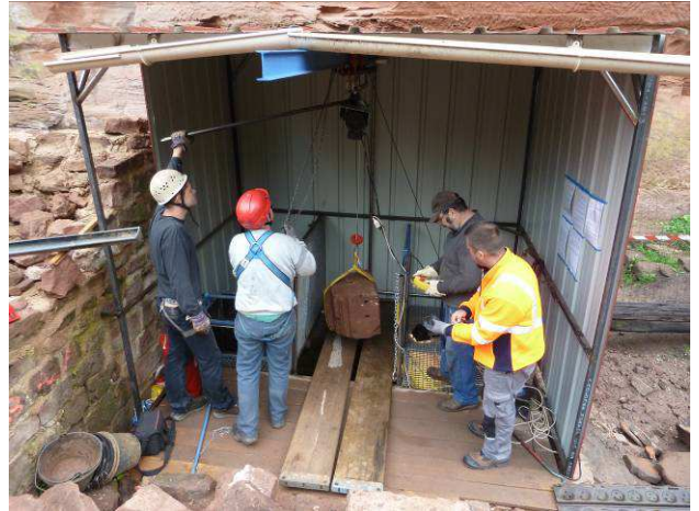
Remontage d'un bloc de pierre depuis le fond du puits
