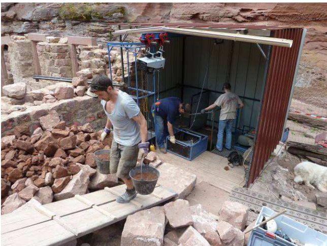
Evacuation de la terre du puits
