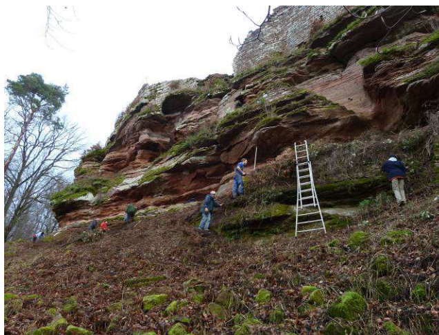
Base du rocher Nord côté Ouest.
