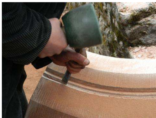
Taille des moulures au maillet et au ciseau
