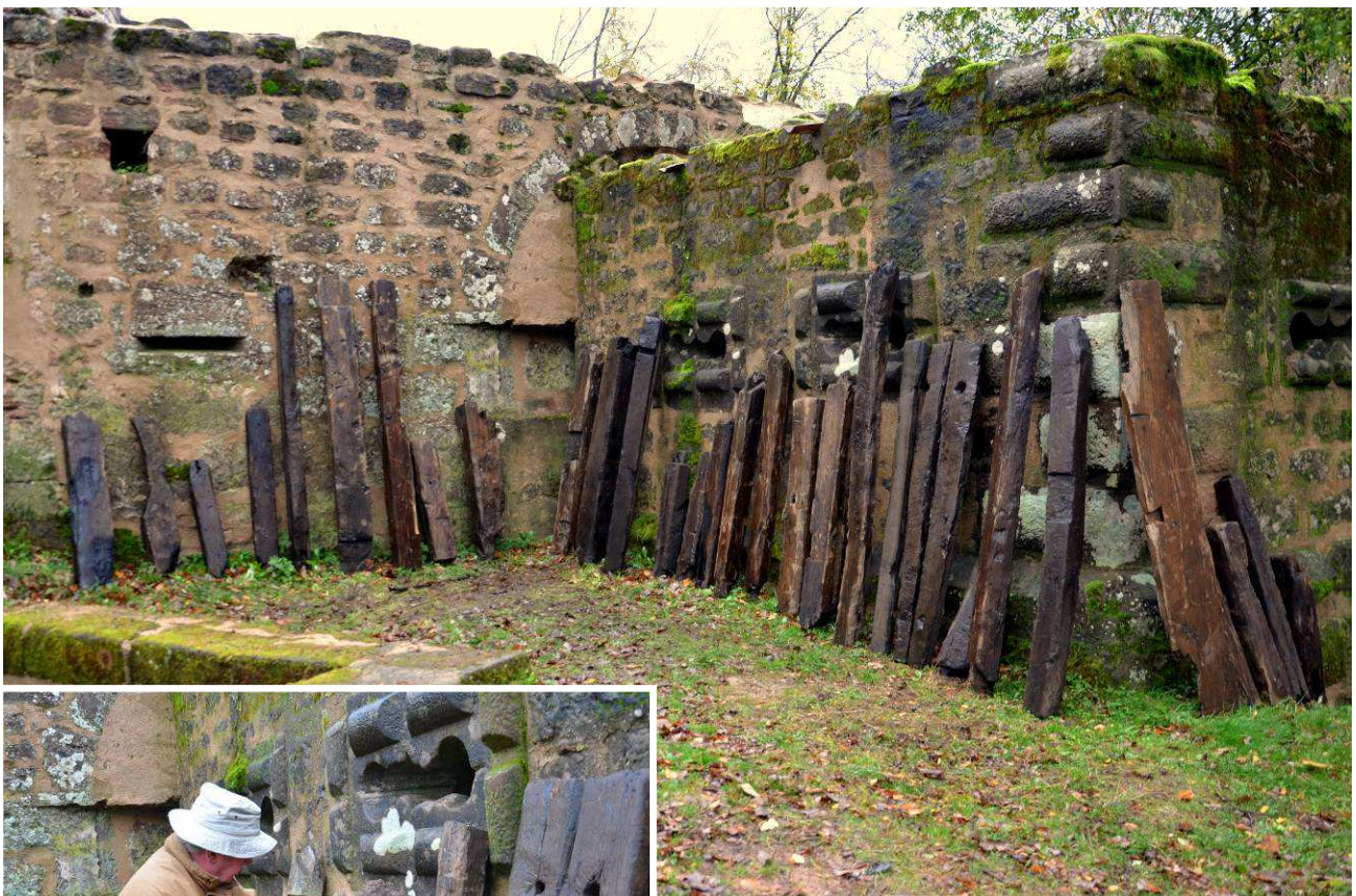
Ensemble des poutres de bois sorti du fond du puits.
