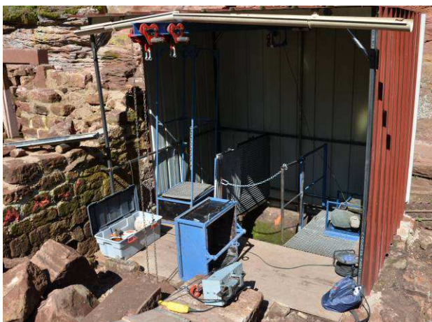
Entrée du puits avec la nacelle et le caisson pour les seaux.
