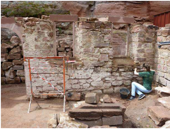
Jointoiement du dessous de la fenêtre du 2 ème local
