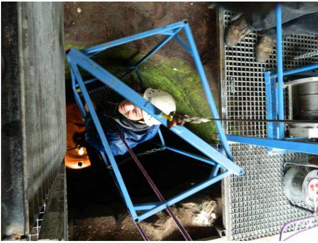
Descente dans le puits avec la nacelle
