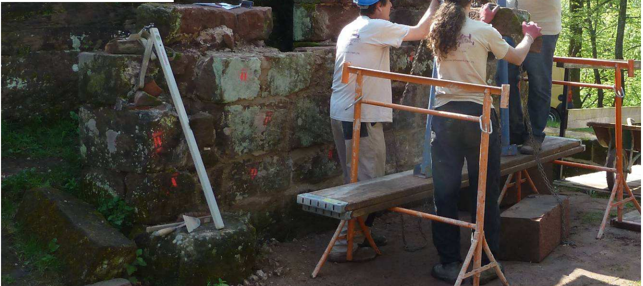
Remontage d'une bouche à feu grâce au portique et au palan
