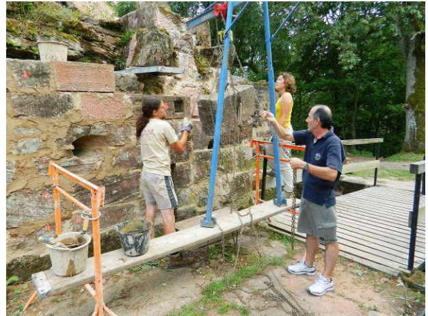
Remontage d'un bloc à l'aide du palan accroché à la « chèvre ».
