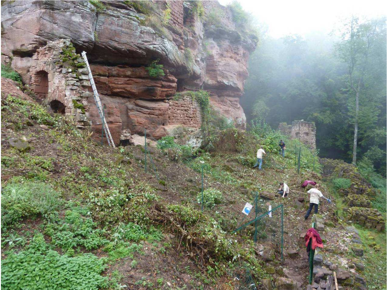
Débroussaillage au pied du chaînage d'angle qui sera remonté en 2014.
