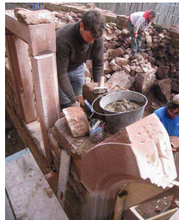
Pose de l'arc de la porte
