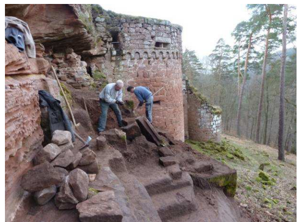
Entrée de la « tour carrée »
