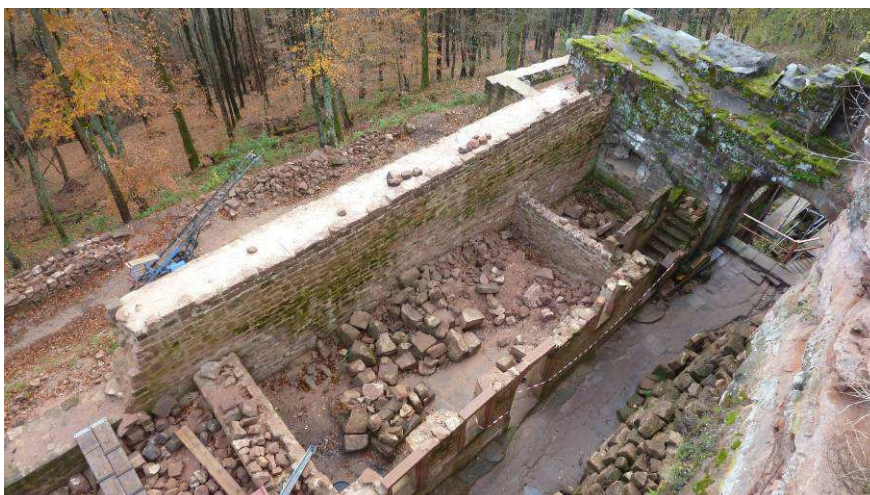
Vue d'ensemble du chantier à la fin des travaux
