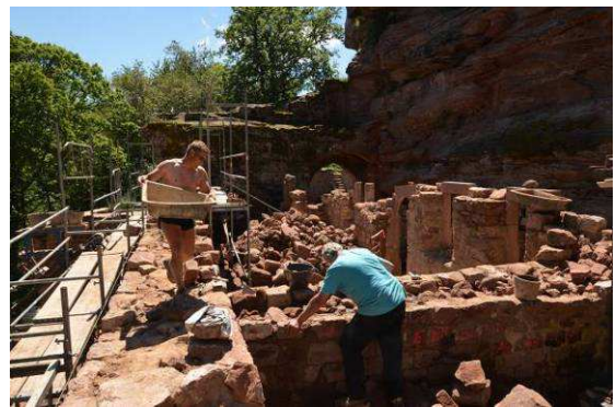
Maçonnerie de l'épais mur du logis Renaissance
