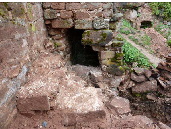
Cheminée avant travaux
