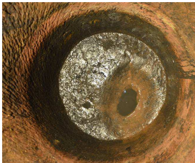
Fond du puits avec la cuvette qui permettait de récupérer les impuretés.
