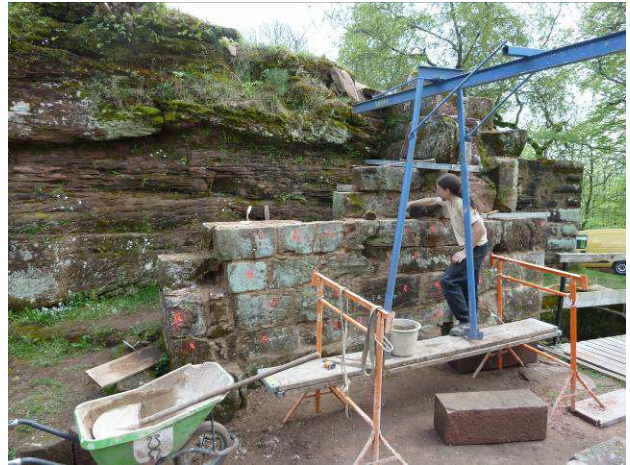
Remontage du mur
