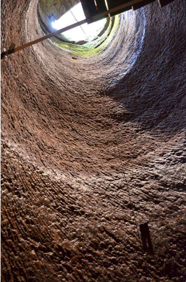
Paroi du puits taillée dans le grès.
