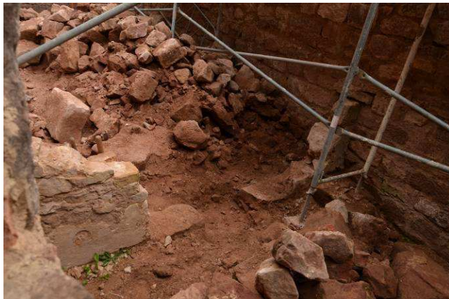
Mur entre les deux locaux après dépose du mur.
