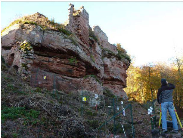
Scannage du logis Nord
