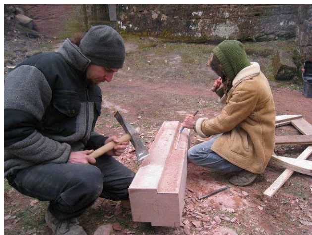
Finition des surfaces au taillant polka
