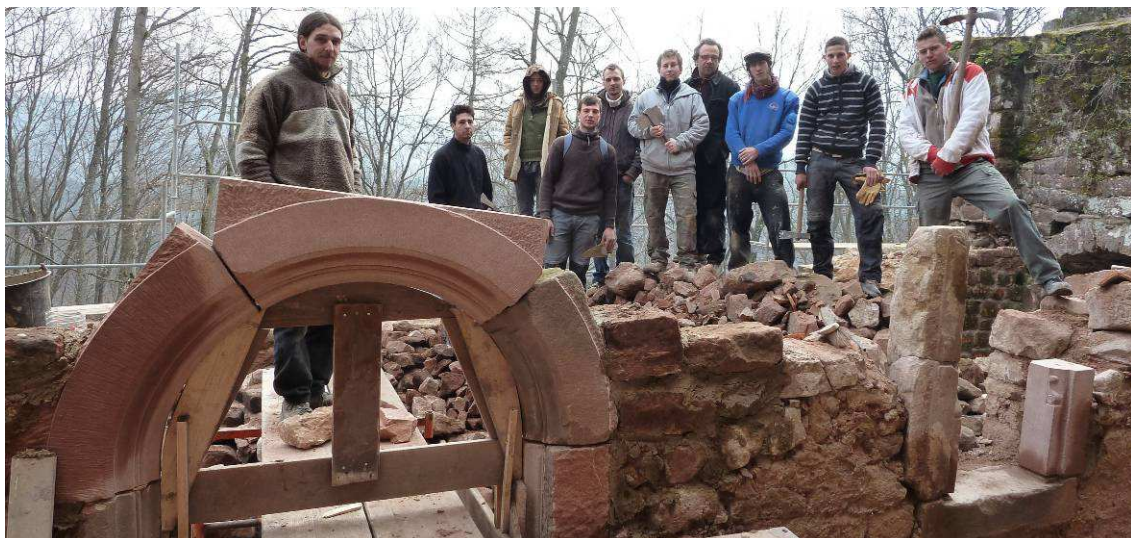
Pose de l'arc de la porte
