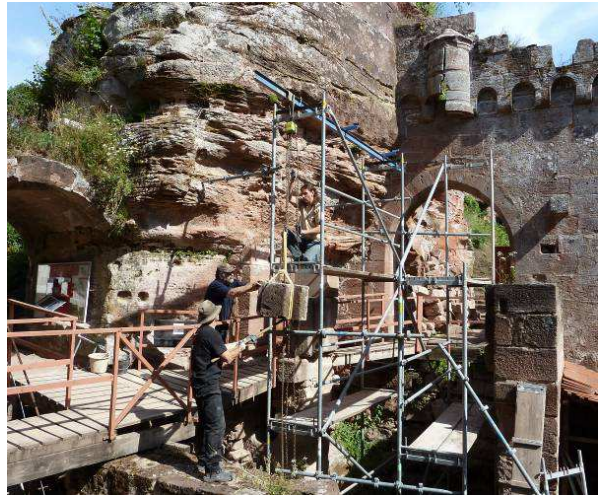
Remontage d'un bloc de la porte piétonne
