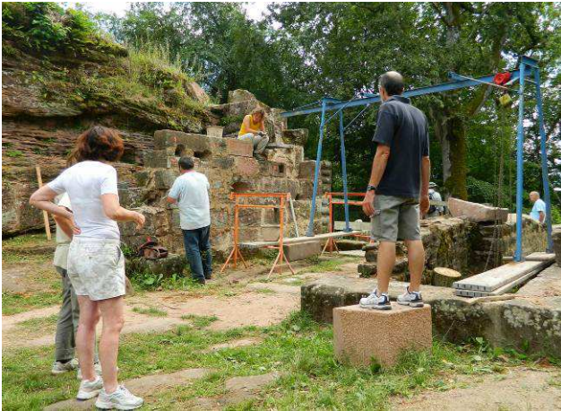
Mur du « sas »
