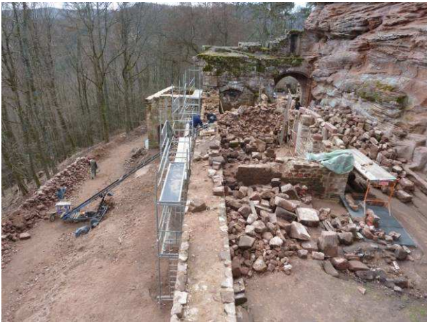
Vue d'ensemble du chantier depuis la tour semi-circulaire
