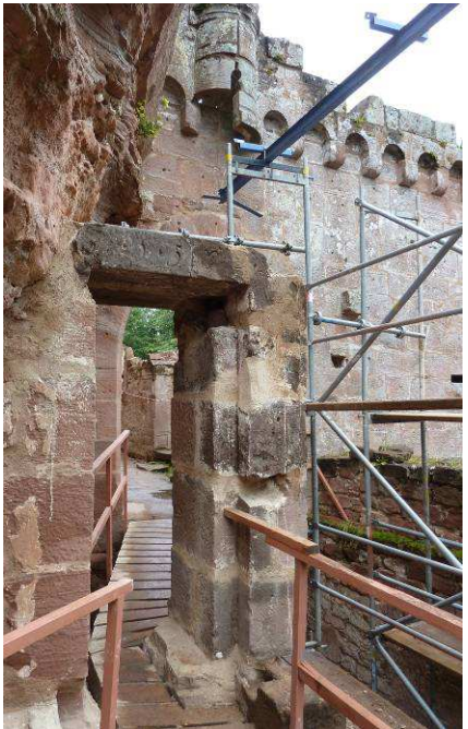
Porte piétonne achevée
