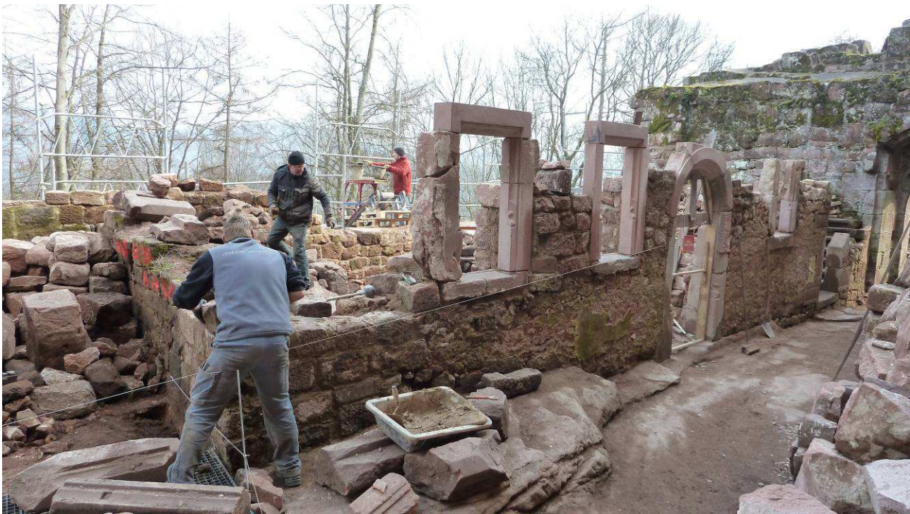
Maçonnage de l'angle Nord du logis Renaissance
