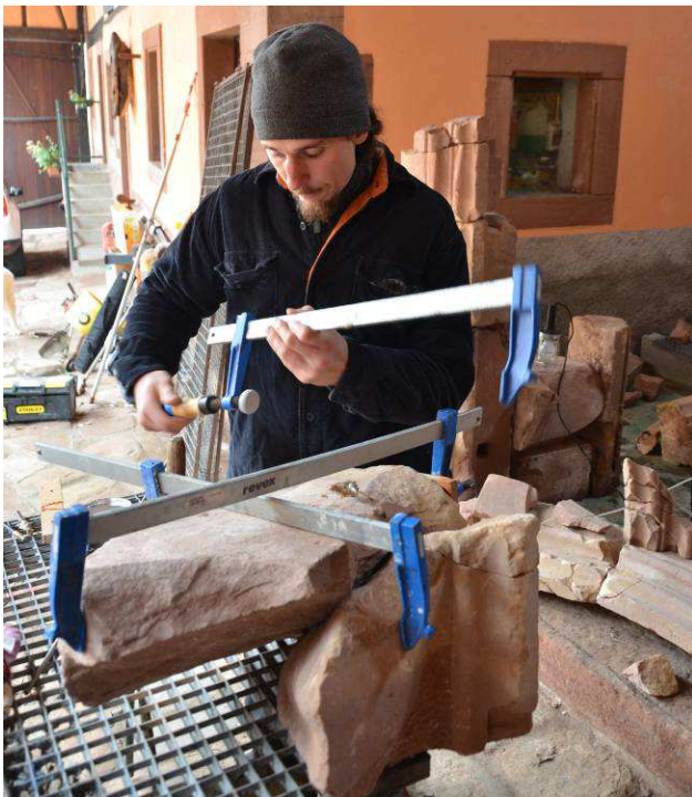
Assemblage de plusieurs blocs de la chapelle.
