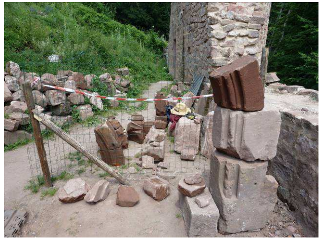
Eléments de l'encadrement de la chapelle trouvés dans le puits
