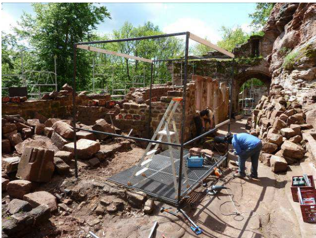
Installation de l'abri au-dessus du puits
