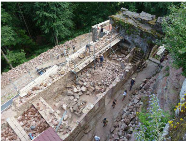
Vue d'ensemble du chantier
