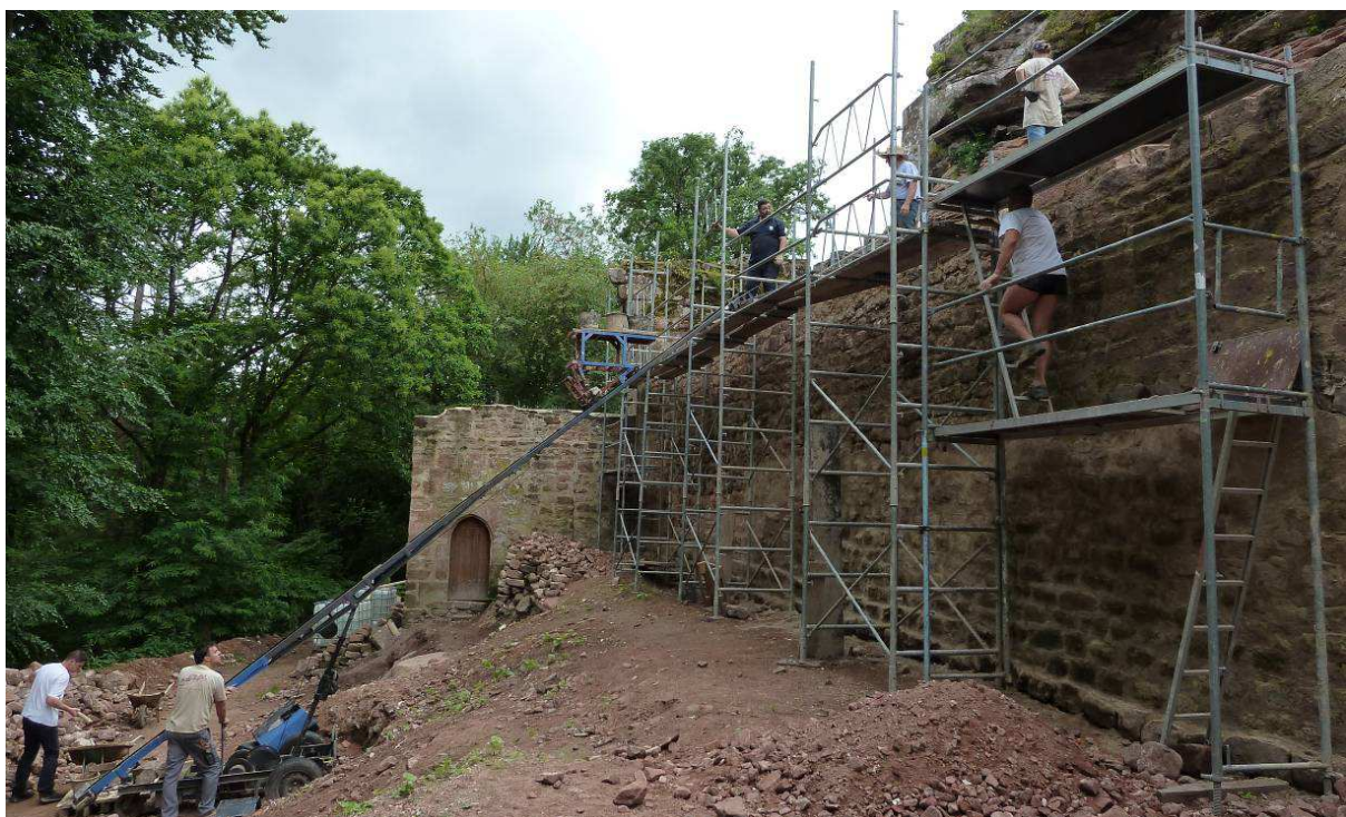
Rempart Est avec le monte-charge.
