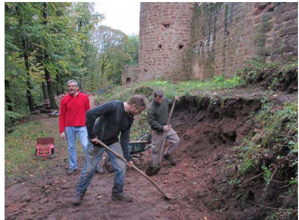
Début de la réalisation de la plate-forme.
