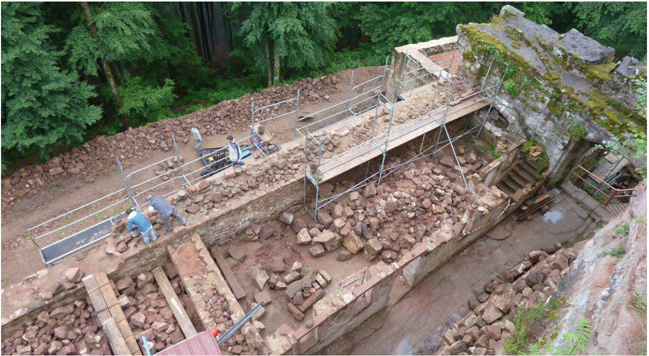
Vue de dessus du logis Renaissance et du rempart Est
