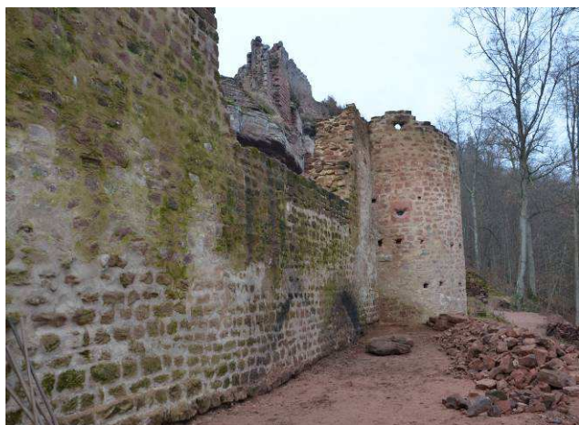
Pied du rempart Est sans le tas de gravât.
