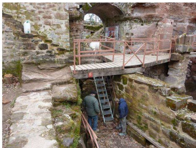
Installation du nouvel escalier métallique
