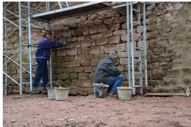
Jointoiement du rempart Est
