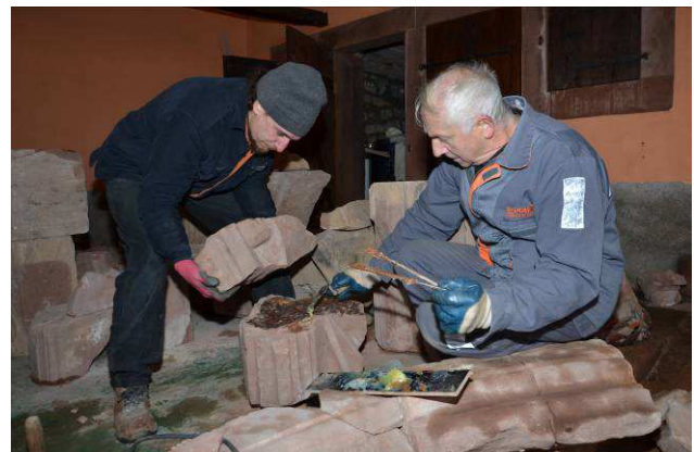
Assemblage de deux pierres de voûte de la chapelle avec de la colle.
