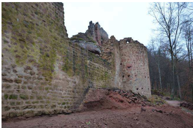
Rempart Est avec le tas de gravât.
