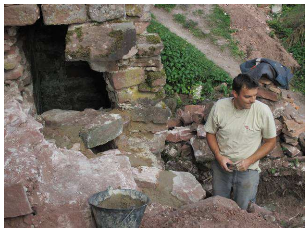
Maçonnerie du conduit secondaire de la cheminée
