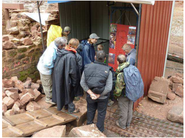
Explications sur les travaux du puits.
