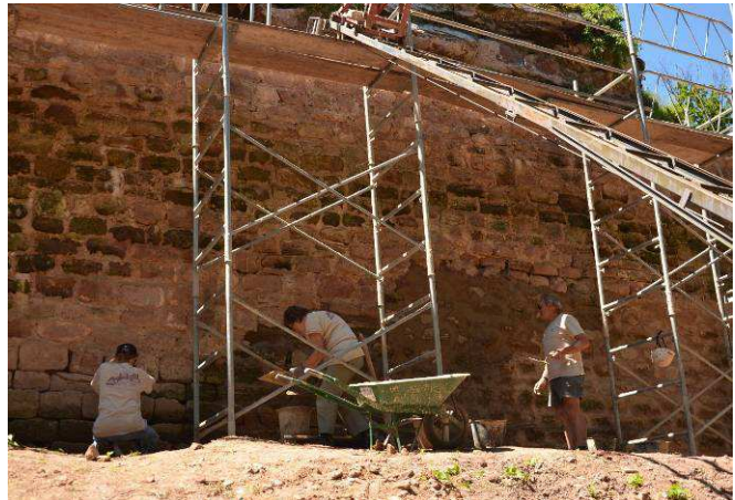
Jointoiement du bas du rempart Est
