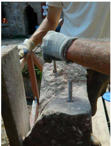
Goujonage du linteau de la porte
