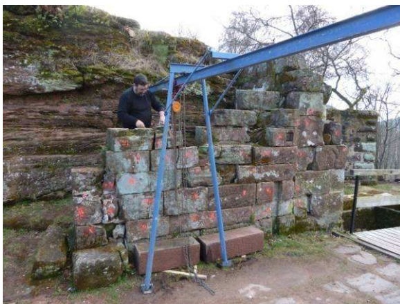
Dépose des blocs numérotés
