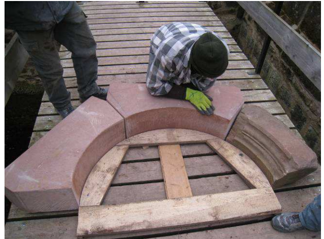
Présentation des voussoirs avant taille des moulures
