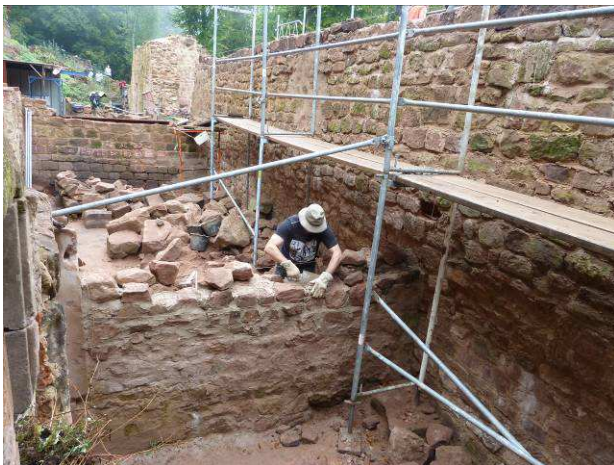
Remontage du mur de refend.
