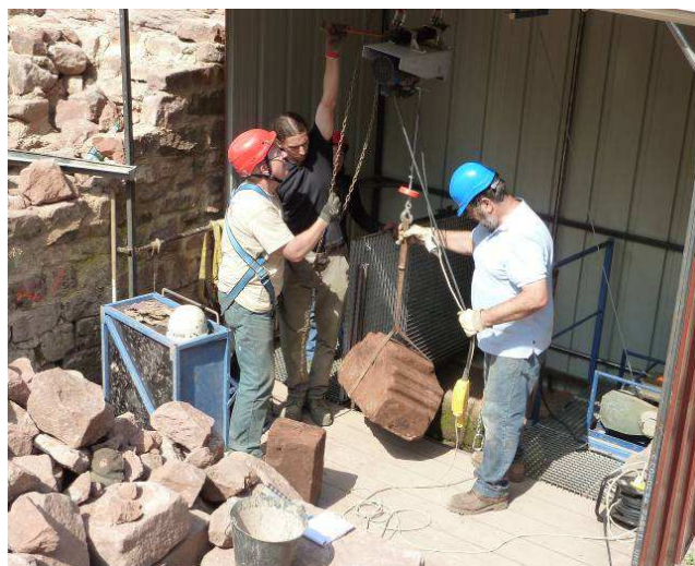
Remontage d'un élément du fond du puits.
