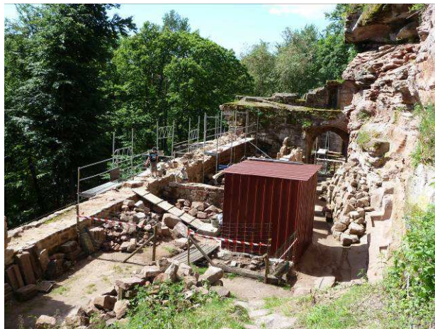
Abri et délimitation de la zone de travaux du puits
