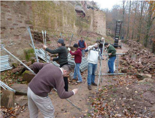
Nettoyage des éléments d'échafaudage
