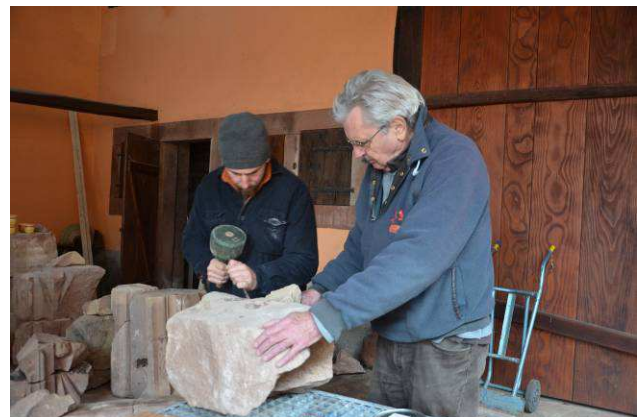
Nettoyage des impuretés avant collage.
