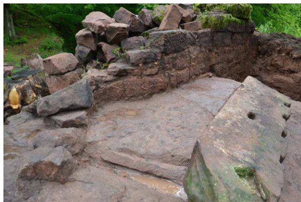
Bloc du donjon avec ses marques de débitage entre un mur et le rocher.
