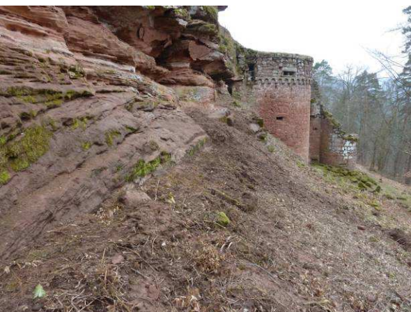
Base du rocher Nord côté Ouest
